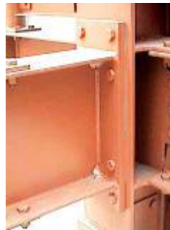
Conexión de placa extremo extendida
