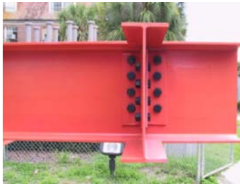
Conexión doble ángulo a) TIPO A
