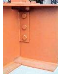
Conexión a cortante
