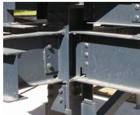
b) Conexión con patines soldados
