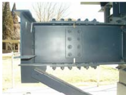
Figura 2.1 Conexión atornillada
