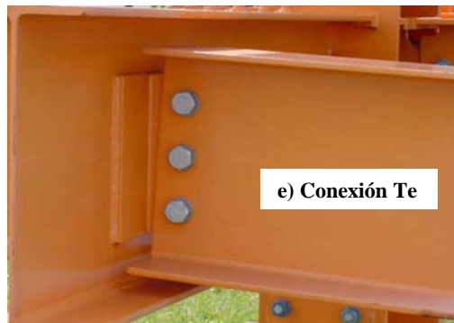
Figura 2.4 Conexión a cortante directo (Murray, 2001)
