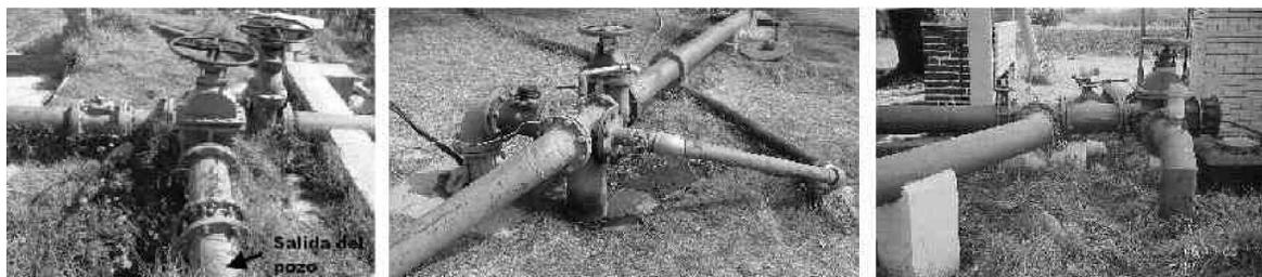
Figura 2.1 Tres casos de tramo recto insuficiente para la correcta colocación de un medidor.
