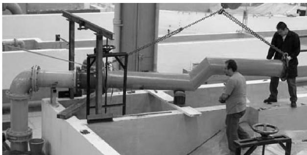
Figura 6.5 Fotografía del armado del tren de descarga.
