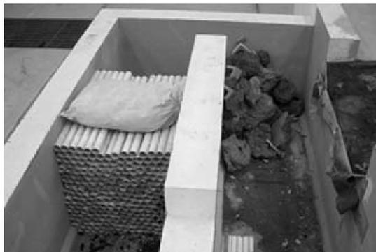
**Figura 5.8 Piedras y tubos de PVC a manera de estabilizador y orientador de flujo en el canal de retorno.**
