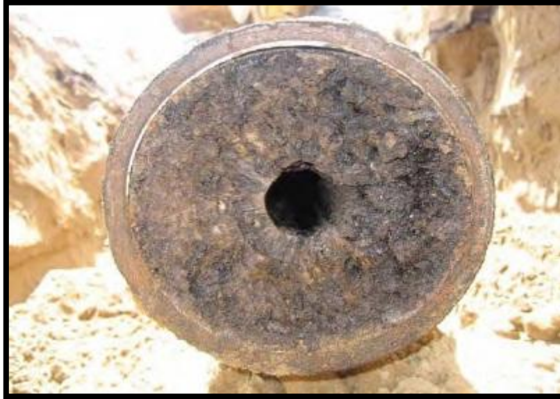
Figura 6.5. Sección de tubería de línea de escurrimiento con depósitos de asfaltenos 18 .
