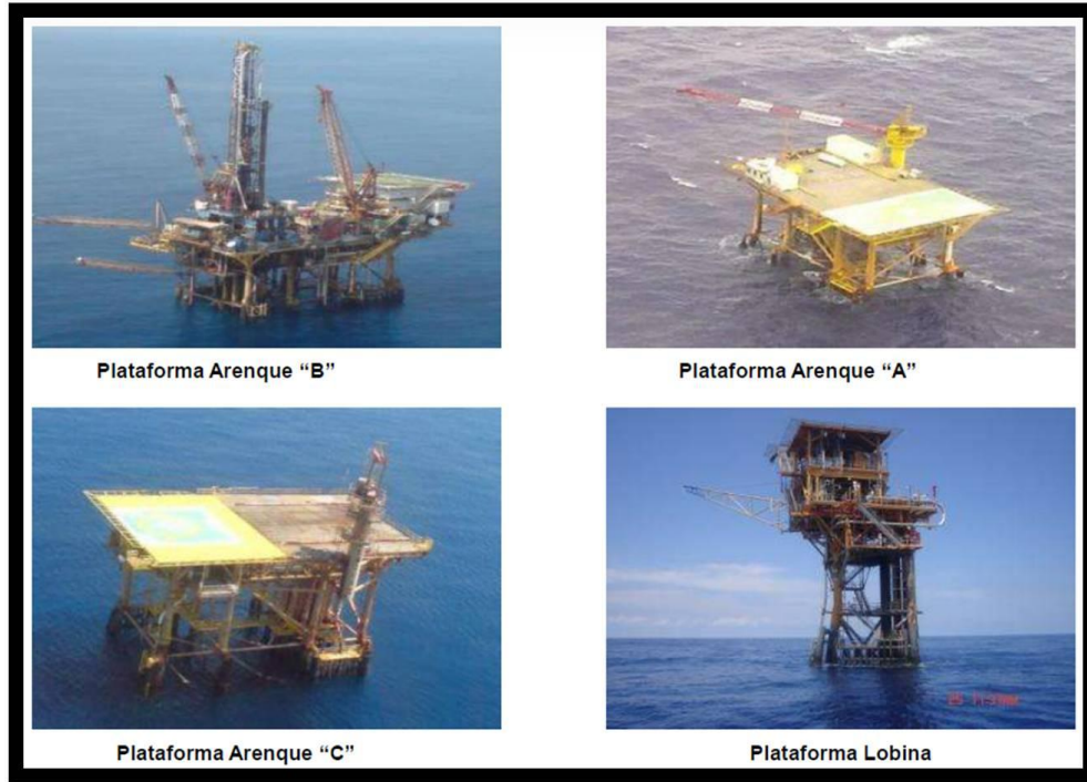
Fig. 4.3. Plataformas del Bloque Arenque (Tomada de PEMEX, 2012).
