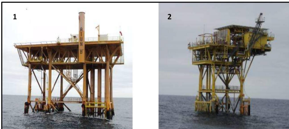
Fig. 4.10. (1) Plataforma Atún B en operación con 12 conductores y (2) Plataforma Atún D nueva sin operar con 3 conductores (Tomada de PEMEX, 2011).
