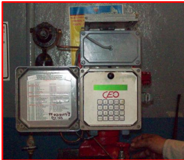
Fig.2.4.- Regulador de gas. Fuente: ENX Compressors.
