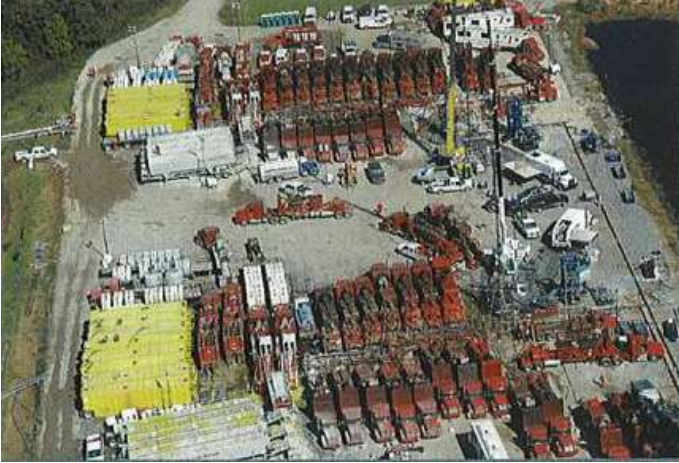
Fig. 36. Tratamiento de fracturamiento simultaneo.
