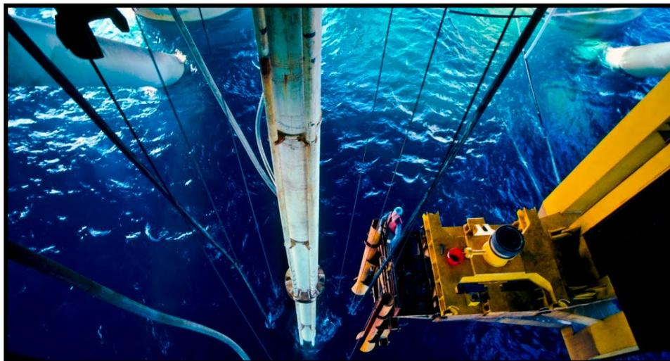
**Imagen 6.4.** Instalación de un BEC en un pozo marino.
