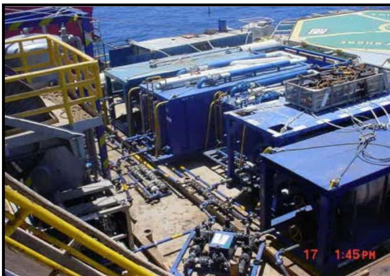
Imagen 7.22. Equipo superficial de un sistema BEC instalado en plataformas del Activo Cantarell.
