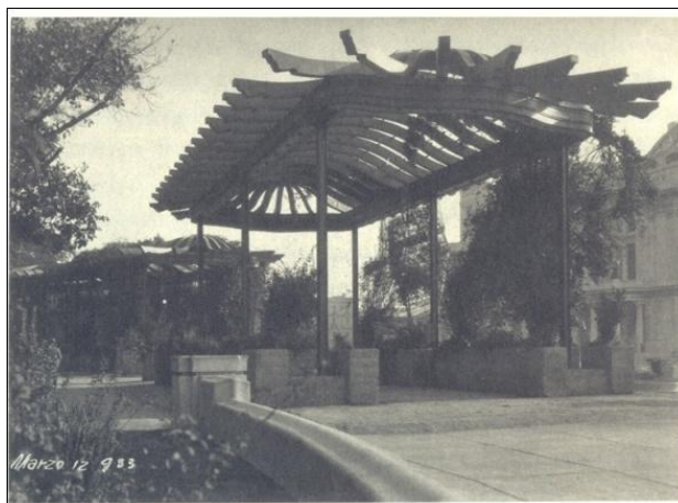
Figura II.XV Pérgola de la Alameda sin revestimientos de mármol de las columnas, 1933. 27
