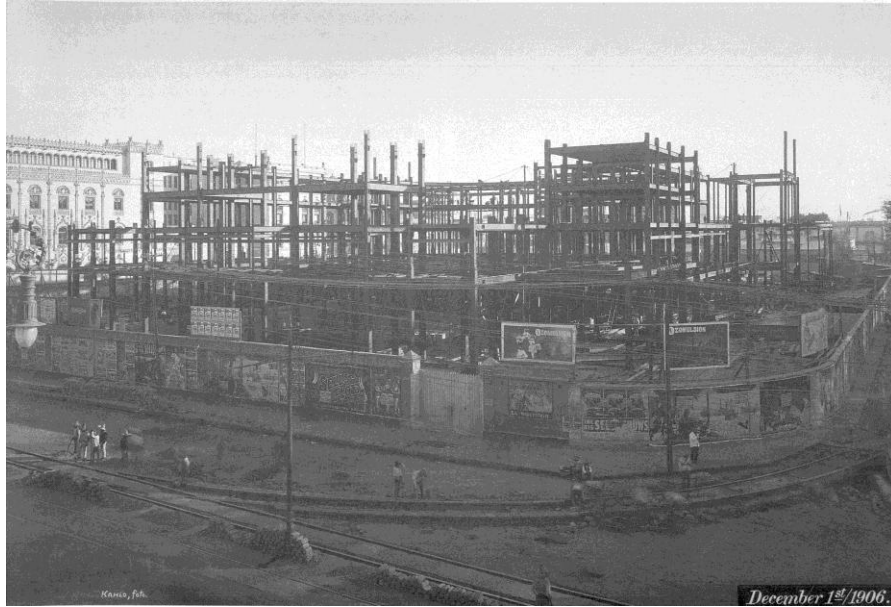
Figura II.VII Montaje de la estructura de acero en la zona del estacionamiento del Nuevo Teatro Nacional. Fotografía de Guillermo Kahlo, 1906. 15
