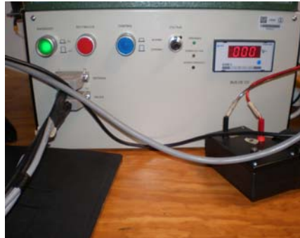
Fig. 41 Convertidor de potencia (Inversor Trifásico)
