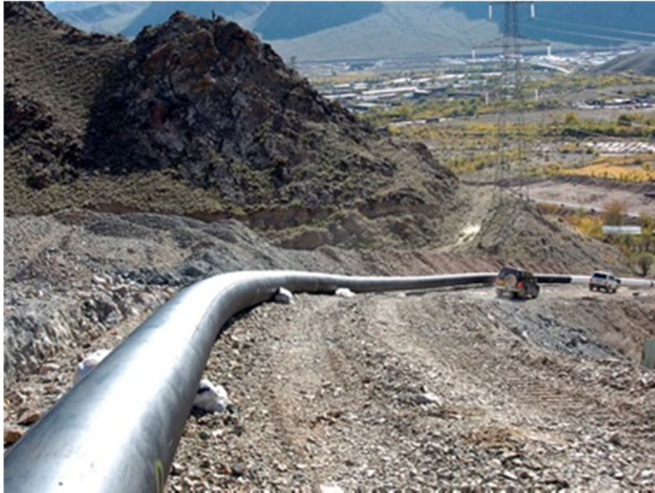
Figura.3.2 Gasoducto tendido en suelo delgado de granito
