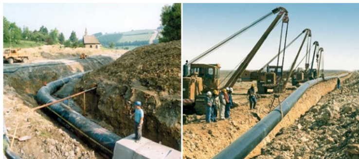
Figura 3.3 Tendido de tuberías de CO 2 en zanjas de bosques y desiertos
