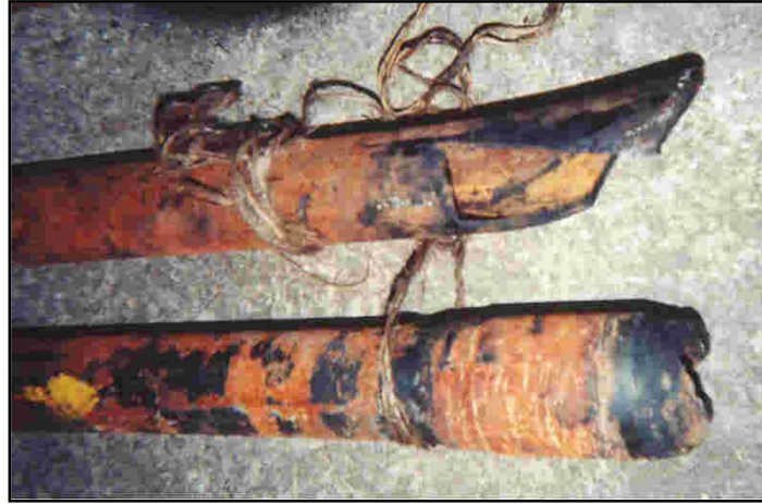
Figura. 3.21 Corrosión de H 2 S en tubería de acero grado P-110 provocando ruptura
