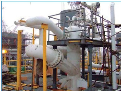
Figura 4.9 Eliminador de gas en plataforma (Kouba et al., 2006).
