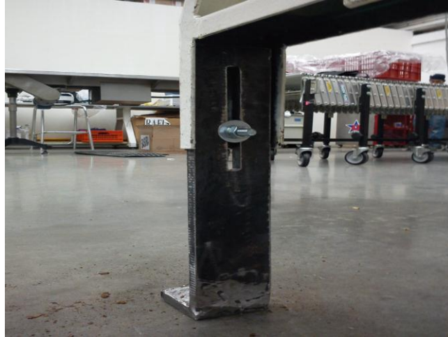
Foto 7. Nivelación de las bandas transportadoras.
