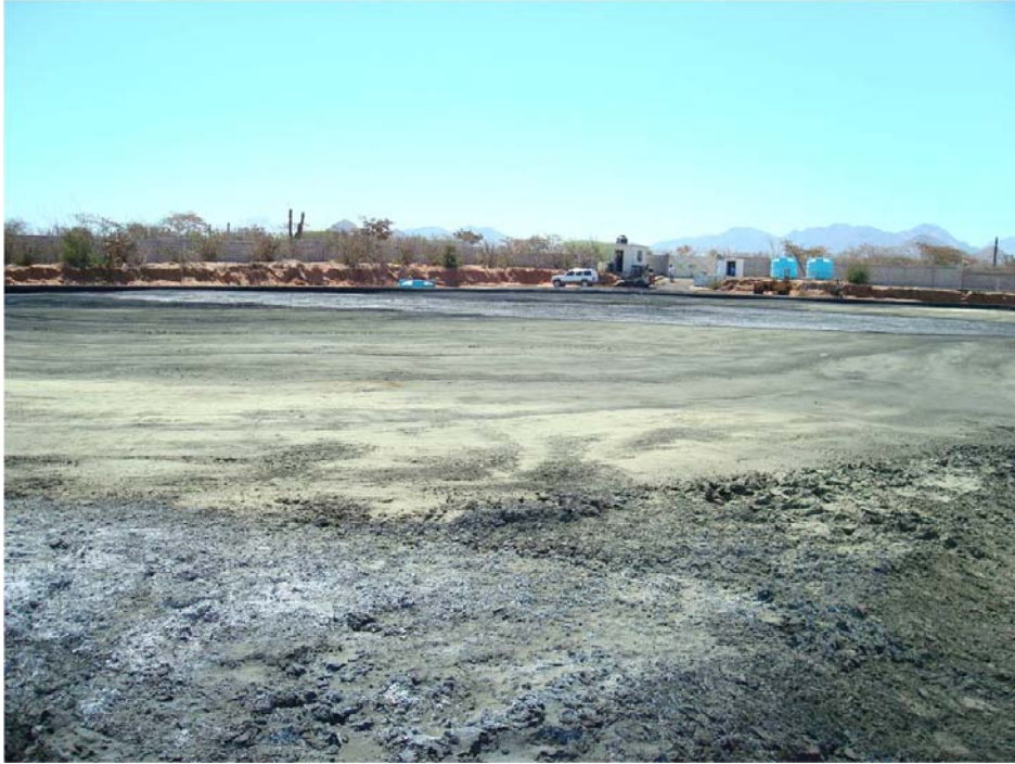
Fotografía 7. Vista de la ceniza en proceso de humectación
