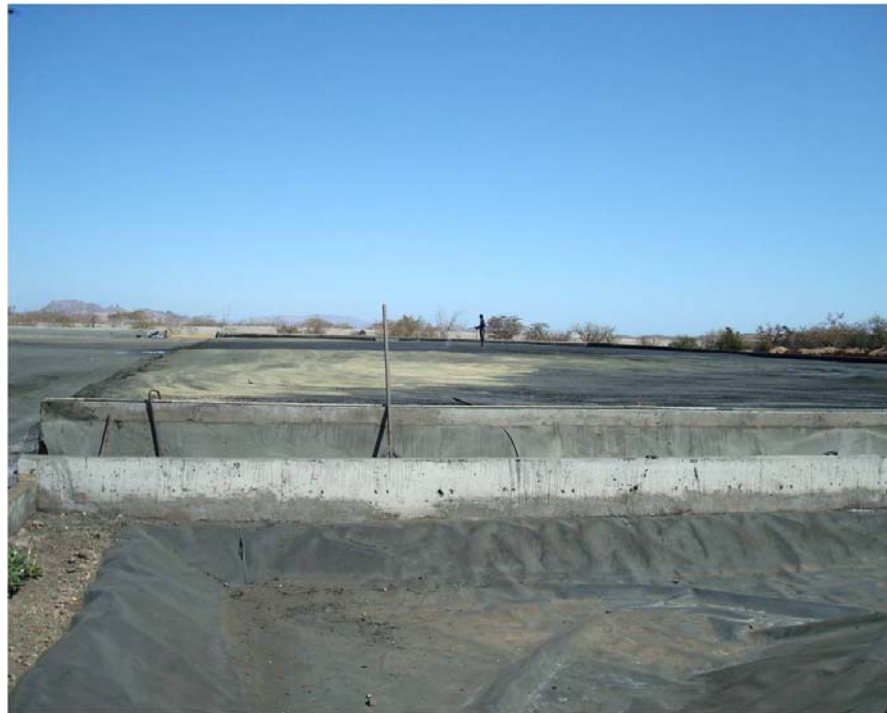
Fotografía 4. Vista de la zona de confinamiento de la ceniza dentro del sitio de disposición
