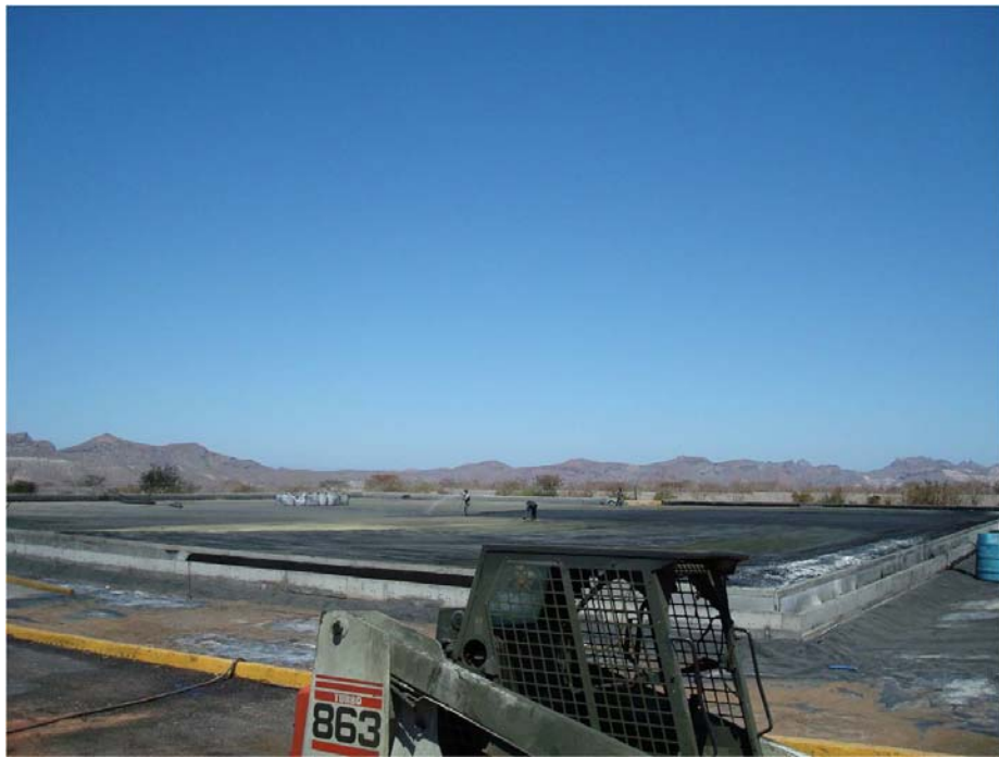
Fotografía 10. Vista general del sitio de disposición controlada
