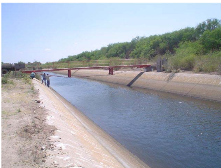
Foto 4- 1: Vista del canal principal de la presa Josefa Ortiz con el puente de aforo
