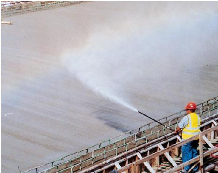
Imagen 5.3 Rociado de agua al concreto para curar manteniendo condiciones de humedad y temperatura adecuadas.
