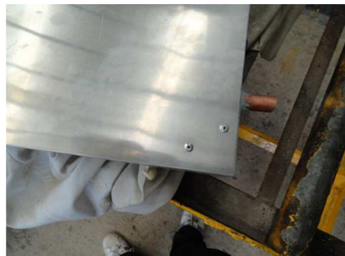
Gráfico A.3.18 Remachado de lámina con marco de aluminio
