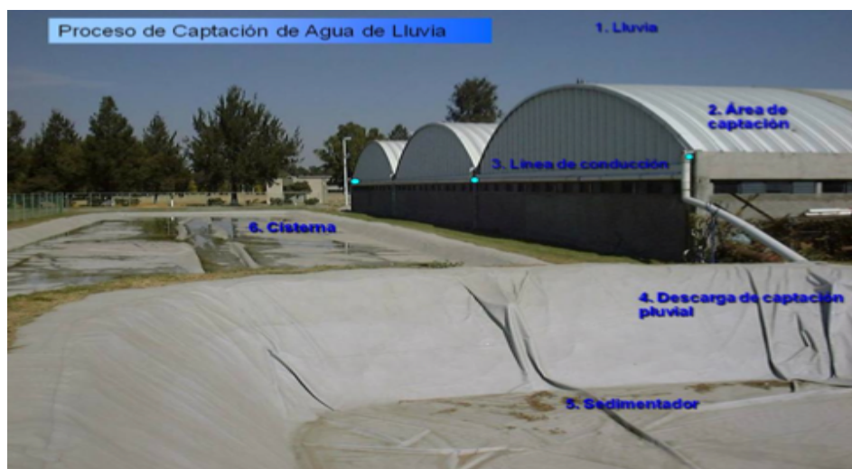
Figura 24. Proceso de captación de agua de lluvia del CIDECALLI.
