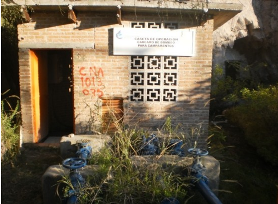
Figura 8c. Censo de aprovechamientos Pozo 1013-35
