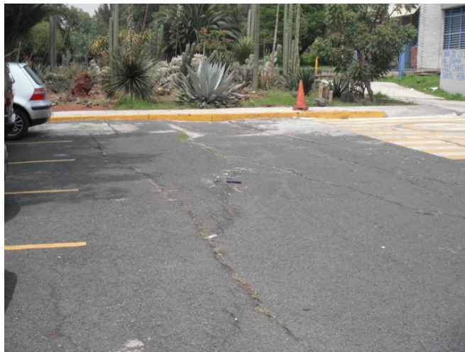
Figura 3.37 Fotografía que muestra el lugar donde fue demolida una construcción con daños irreparables causados por fracturas. En la actualidad es un jardín de cactáceas.
