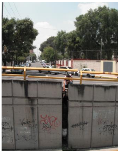
Figura 4.27 Fotografía que muestra la separación entre el muro de contención, de la Av. China.
