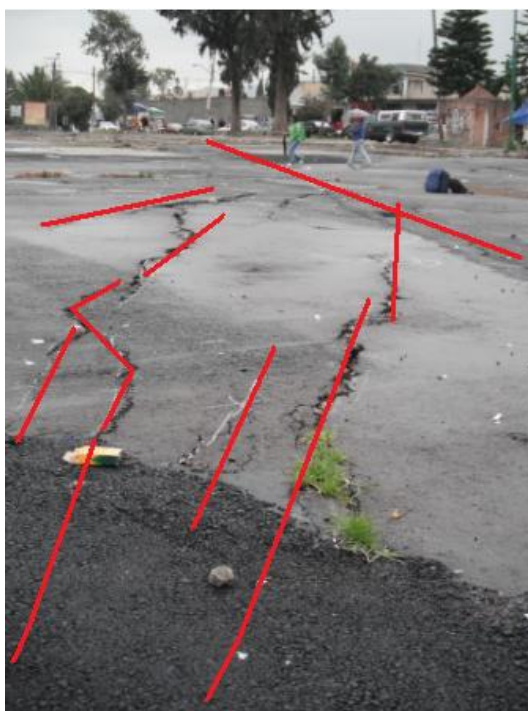
Figura 3.48 Fotografía de las principales fracturas medidas en una explanada del poblado de San Juan Ixtayopan.
