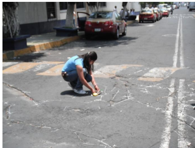
Figura 1.3 Área fracturada delimitada
