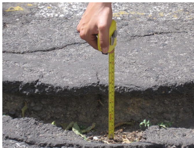
Figura 1.9 Medición del desplazamiento vertical.
