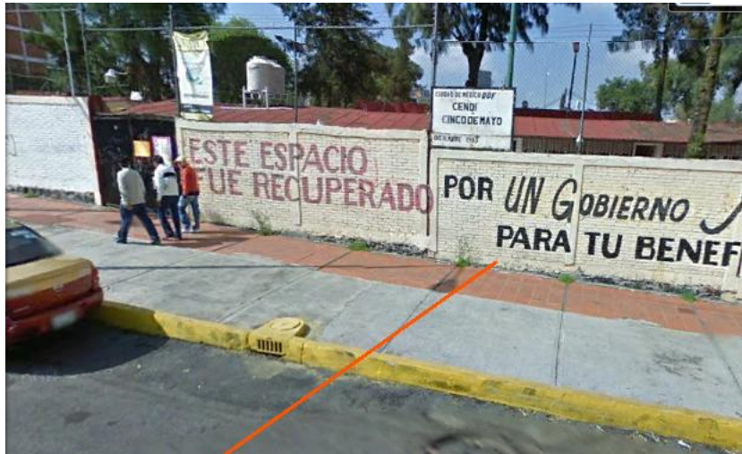
Figura 4.28 Fotografía del CENDEI afectado por los fracturamientos
