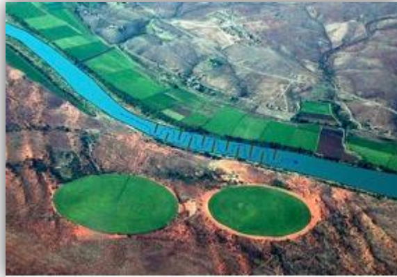
Figura 7. Imagen aérea que muestra la construcción de muros en forma de “L” para la recarga, aumentando el tiempo de contacto entre la superficie del terreno y el agua Foto: (Fuente: Fernández Rubio. 2011).
