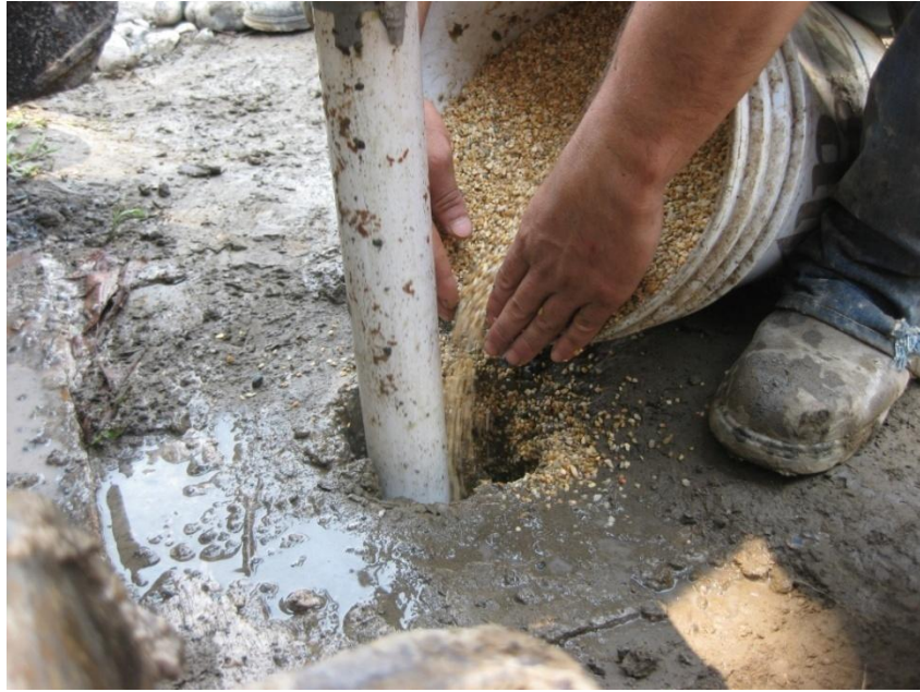
Colocación del filtro de grava del sondeo 2
