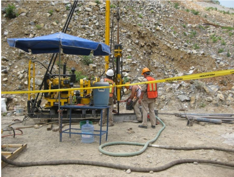
Perforación sondeo 5
