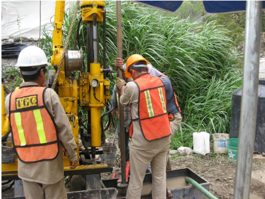
Perforación del sondeo 4
