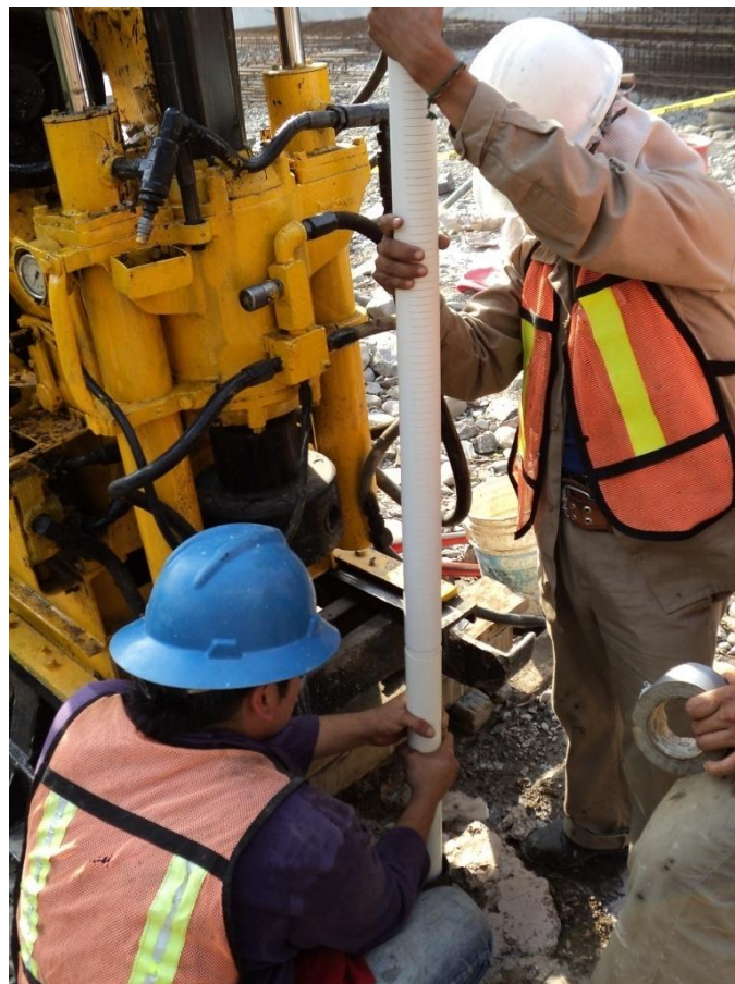
Entubamiento del sondeo 1
