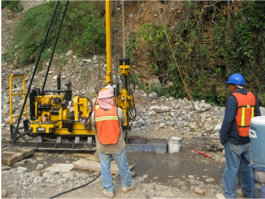
Perforación del sondeo 3
