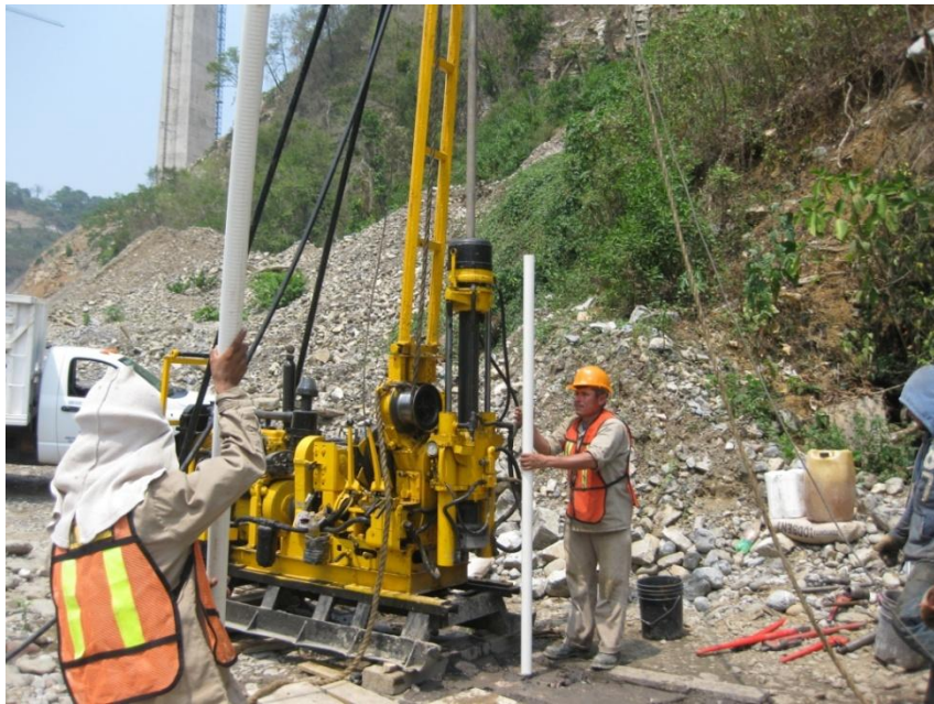
Entubamiento del sondeo 3
