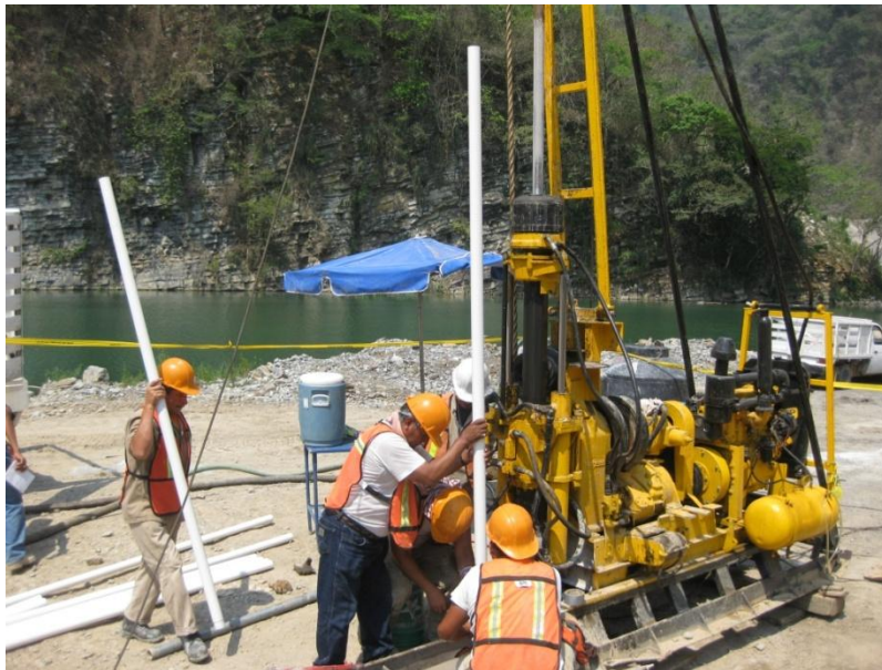
Entubamiento del sondeo 5
