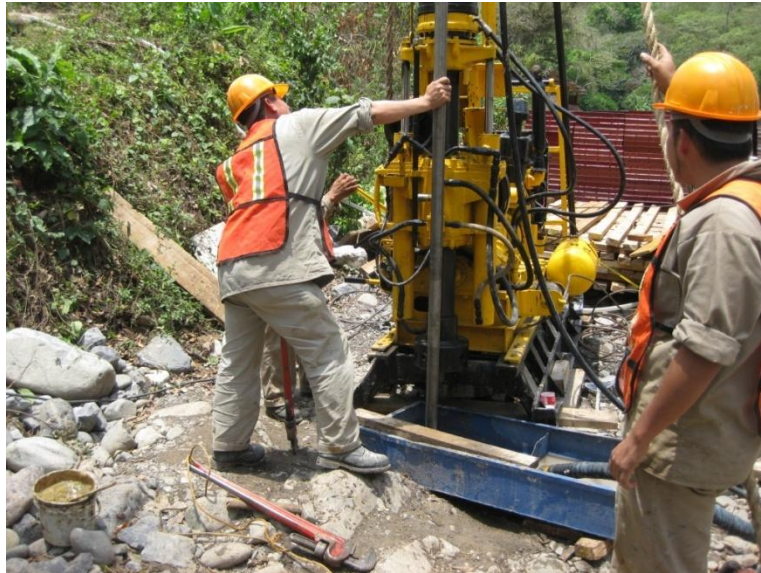
Perforación del sondeo 1
