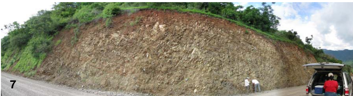
Foto 7. Andesita de la carretera de Buenavista a Coxcatlán con diaclasamiento vertical.
