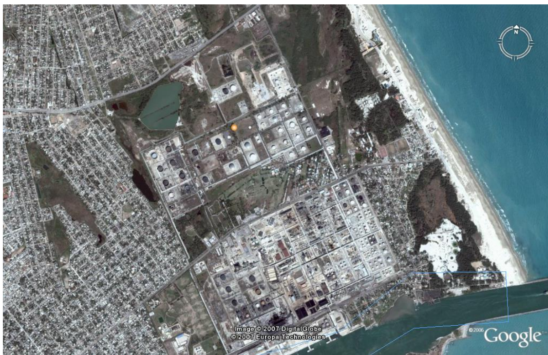
Figura 32 Refinería Francisco I. Madero, Tampico Tamaulipas Fuente Google Earth 2007
