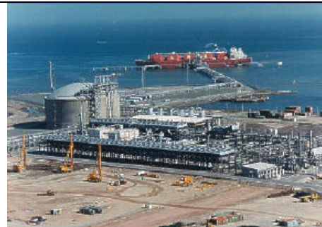
Figura 2.12 Terminal marítima de GNL
