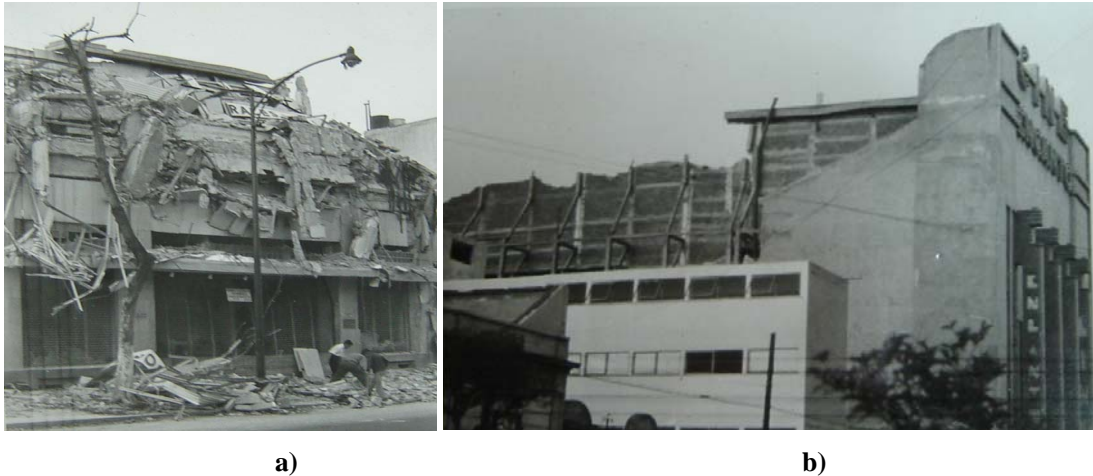
Figura 2.6 Colapsos parciales: a) edificio en Insurgentes # 377, sólo la planta baja quedó en pie y b) Cine Encanto que perdió el techo y parte de los muros.
