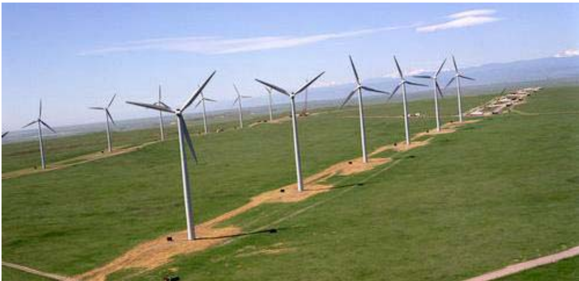
Figura V.20. Presentación de la imagen del parque simulado durante su construcción
