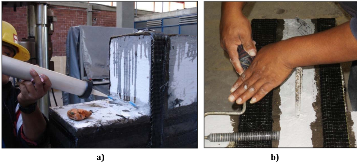
Fig. 5.5. Rehabilitación y reforzamiento del espécimen: a) Inyección de la resina epóxica a través de las boquillas; b) Colocación de las bandas de FRP sobre el espécimen
