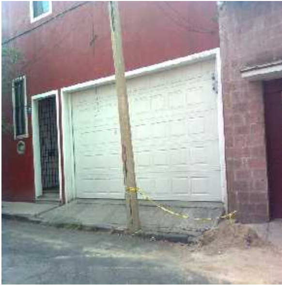
Figura 3.16 Poste colocado en acceso vehicular
