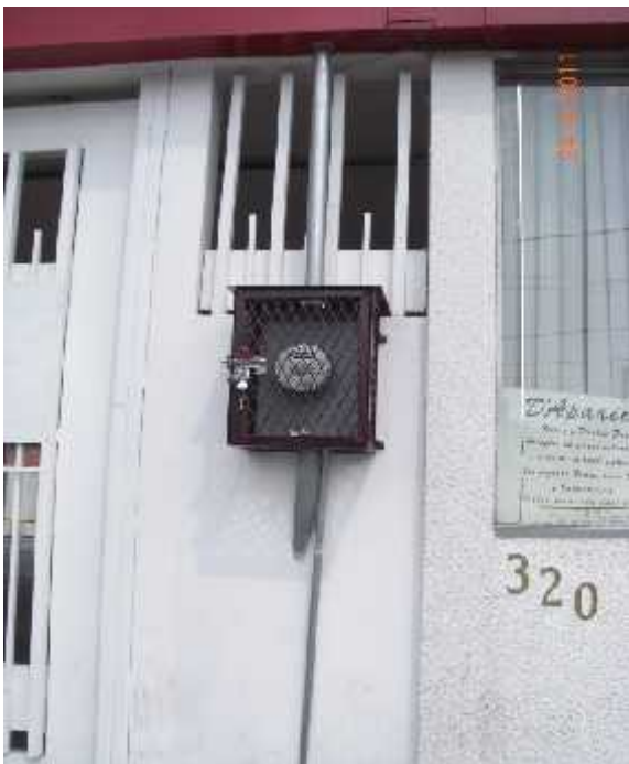
Figura 4.8 Foto tomada de acometida aérea a equipo de medición
