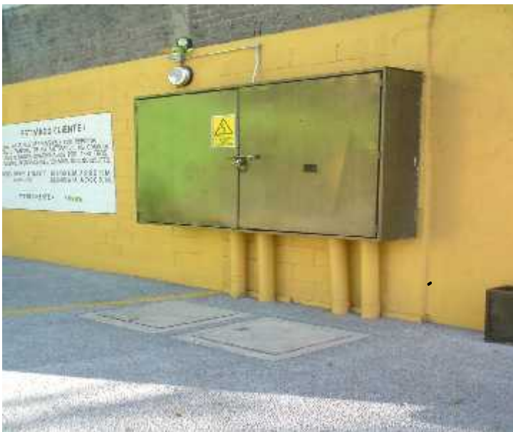
Figura 4.12 Foto de concentración de medidores protegida con gabinete y puertas metálicas
