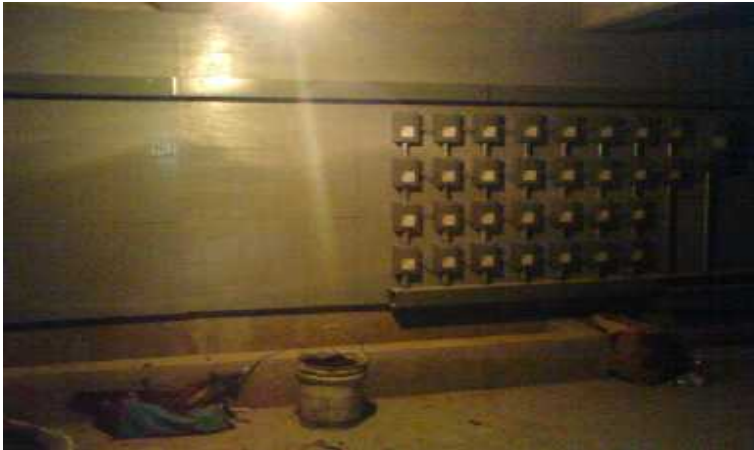
Figura 4.11 Foto con de obra civil terminada para recibir acometida subterránea en nivel sótano
