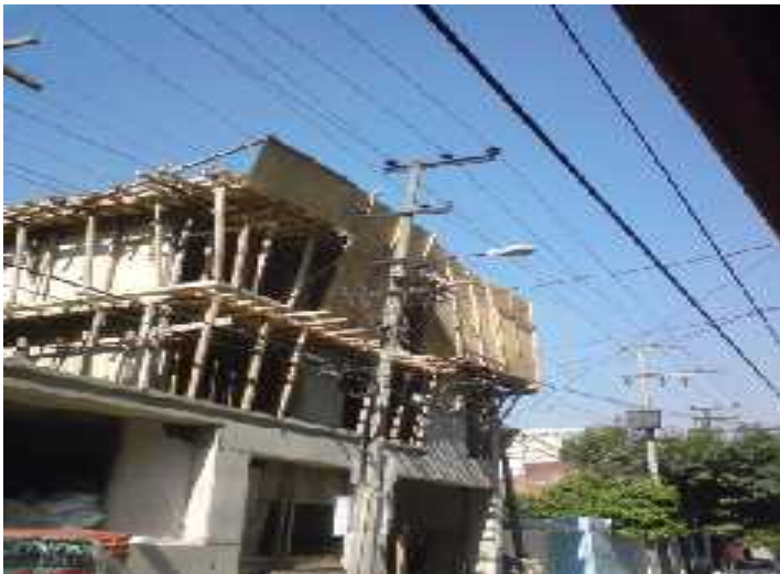
Figura 4.2 Foto tomada en la construcción de un condominio
