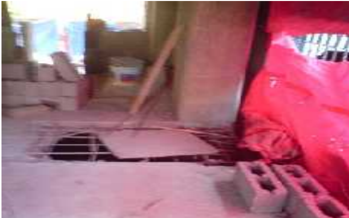
Figura 4.1 Foto tomada en la construcción de unos departamentos
