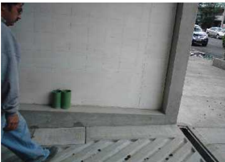
Figura 4.13 Foto de obra civil terminada para acometida subterránea
