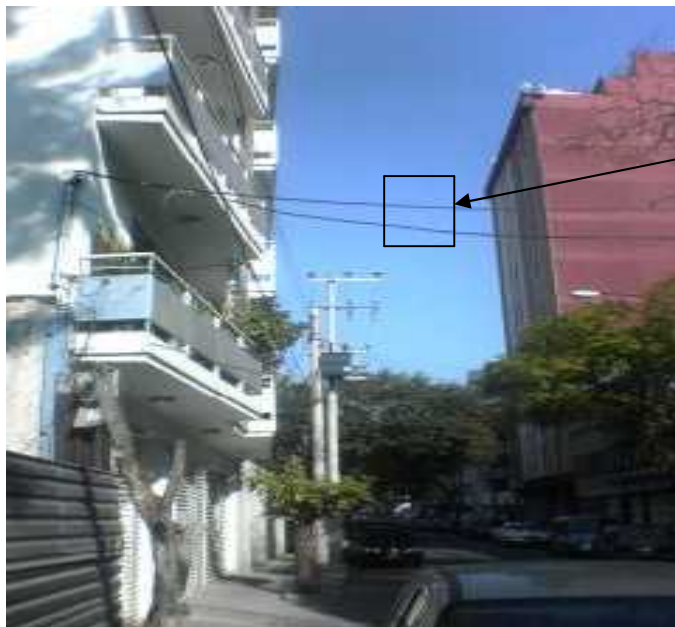
Figura 3.4 Foto ilustrando la acometida cruce arroyo en baja tensión con la altura requerida
