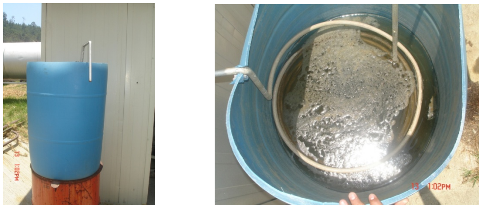
Figura 6. Vistas del condensador de la LAPEM. Fotografías del 13 de mayo del 2011.
