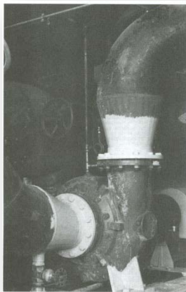
Figura 78.- Bomba con succión en cantiléver
