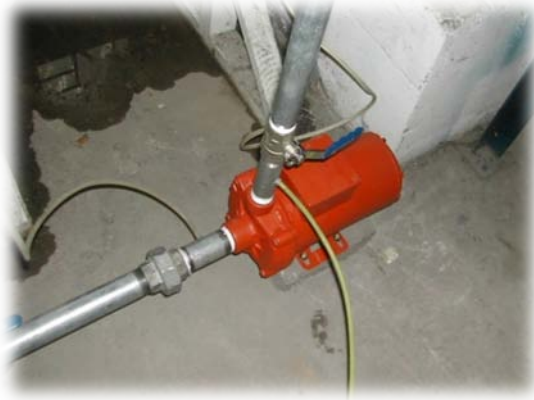
Figura 63.- Bomba Centrífuga y Válvula Esférica
