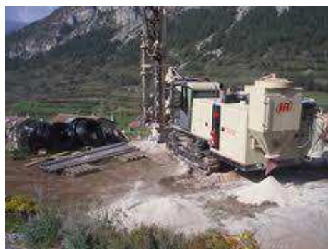
Fig. 2.6 Perforación de un pozo Geotérmico
