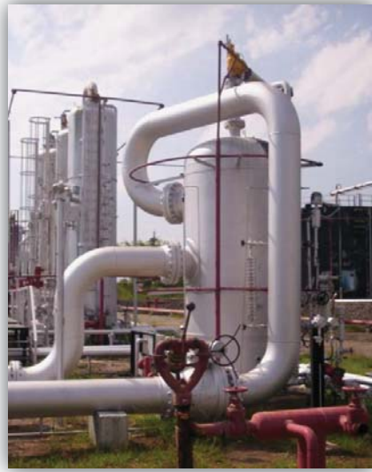
Figura 2.5 Separador de flujos
