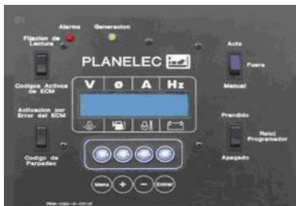
Fig. 1.7. Control PEM CAD de plantas eléctricas
