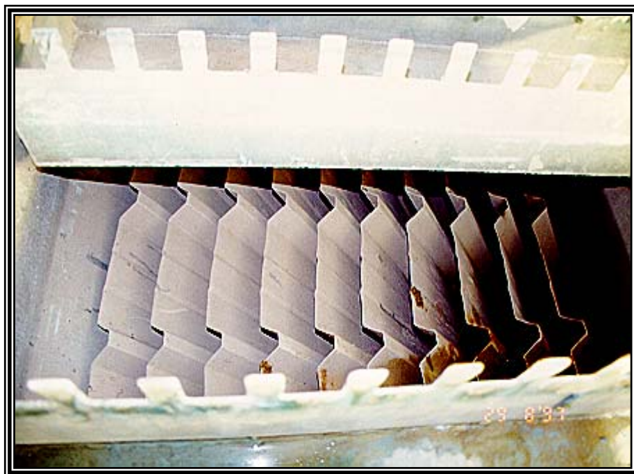
Figura 3.4. SEDIMENTADOR DE PLACAS
