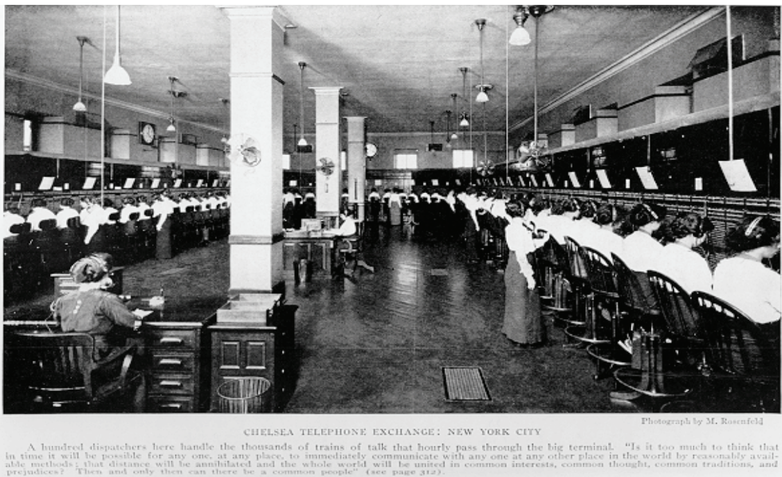
Figura 2.2. Central telefónica de Nueva York a principios de 1900's.
