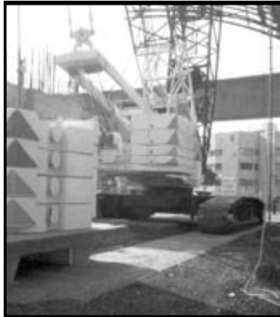
Figura 4.12. Preparación de la maniobra con grúas
