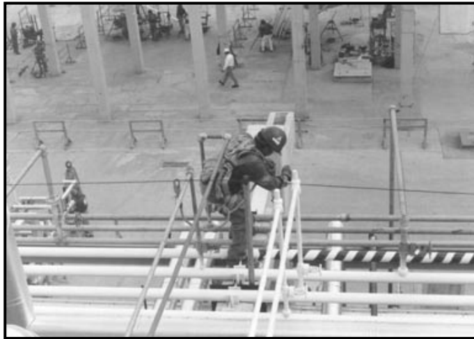
Figura 4.18. Trabajos en altura
