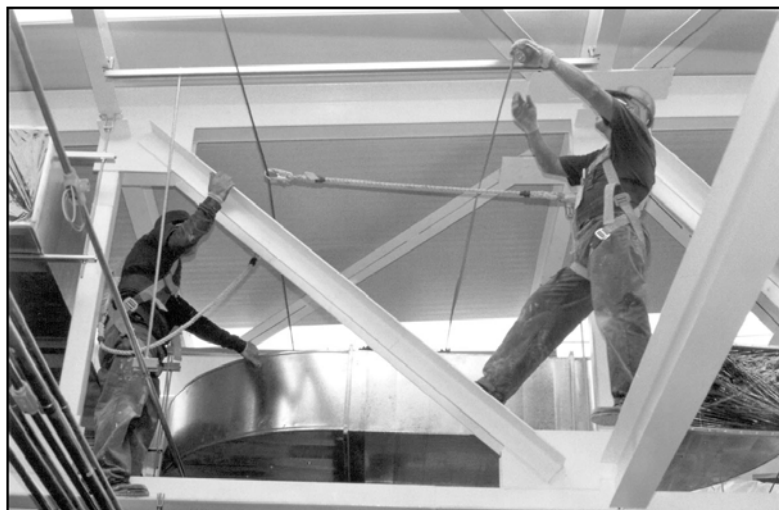
Figura 4.21. Instalación de aire acondicionado
