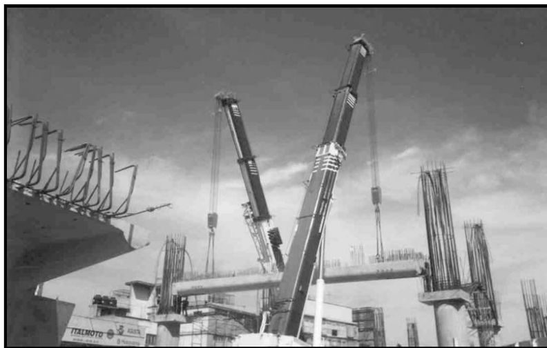
Figura 4.15. Ejecución de maniobra con grúas
