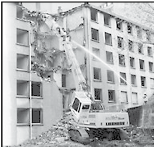
Figura 4.27. Trabajos de demolición con maquinaria
