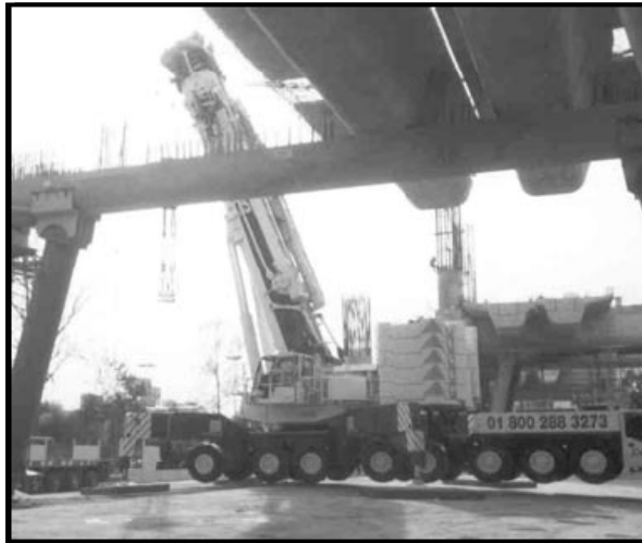
Figura 4.11. Preparación de la maniobra con grúas
