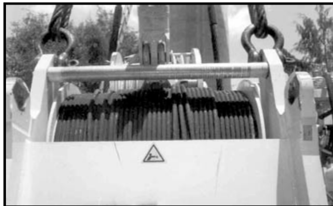
Figura 4.14. Preparación de la maniobra con grúas
