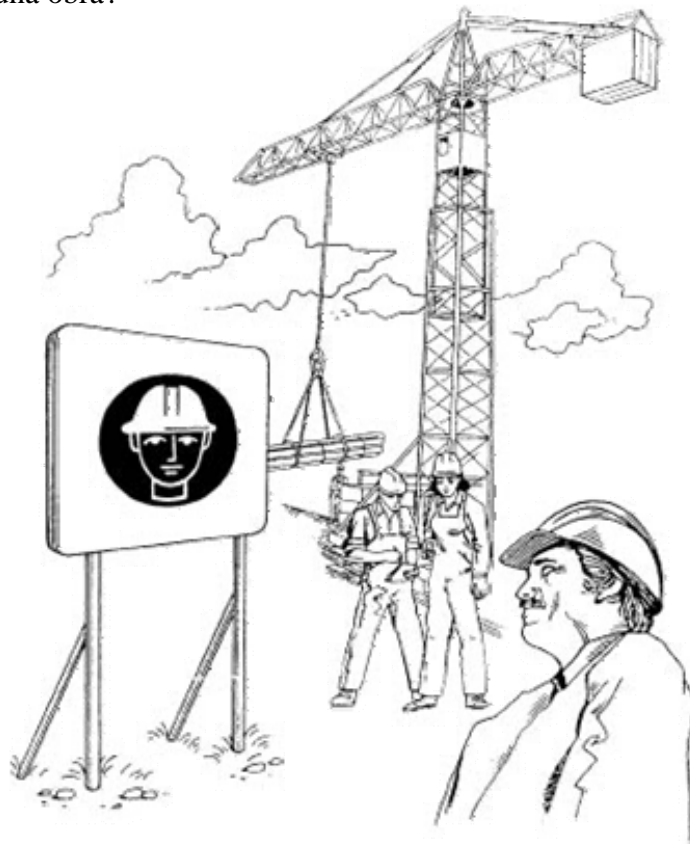
Figura 5.1. Zonas de cascos. Todas o casi todas las partes de una obra en construcción deben estar marcadas como zonas donde el uso de cascos es obligatorio.
