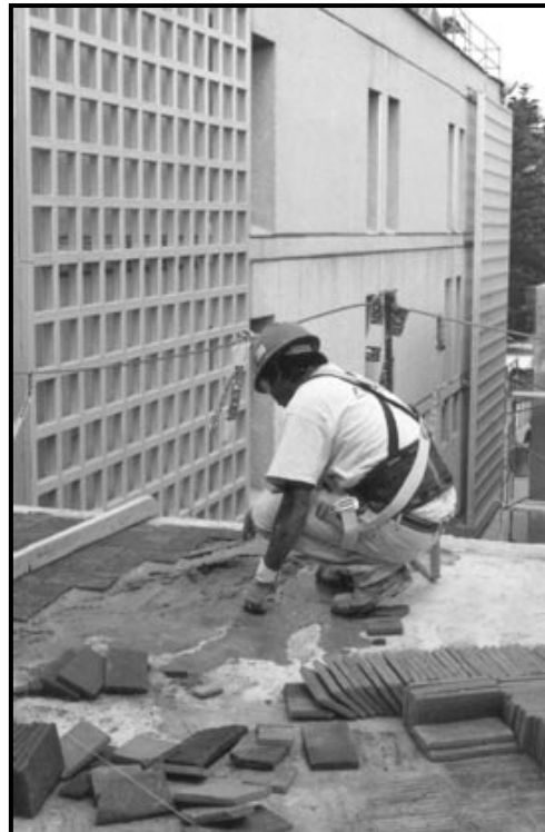
Figura 4.20. Enladrillado de losa
