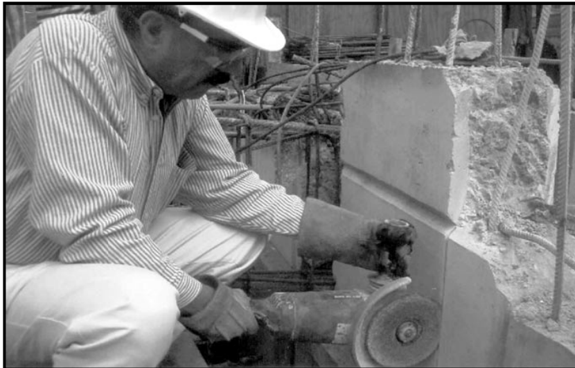
Figura 4.4. Operación de cortadora de concreto y asfalto
