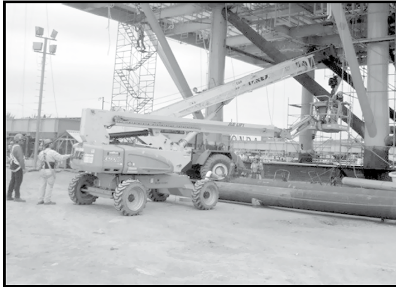
Figura 4.9. Uso de plataformas mecánicas
