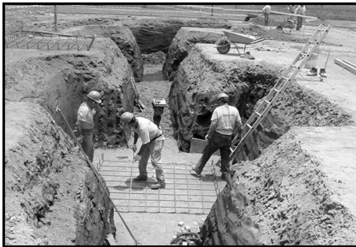
Figura 4.22. Excavación de zanjas
