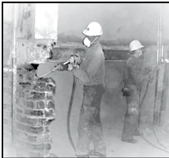
Figura 4.25. Trabajos de demolición manual
