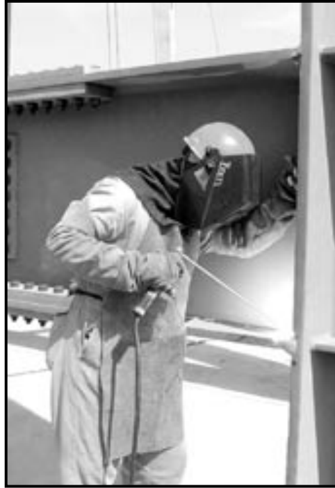
Figura 4.19. Trabajos de soldadura eléctrica
