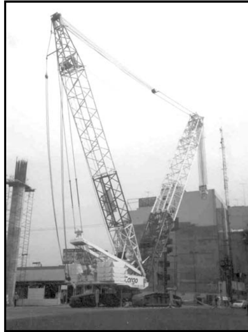
Figura 4.13. Preparación de la maniobra con grúas
