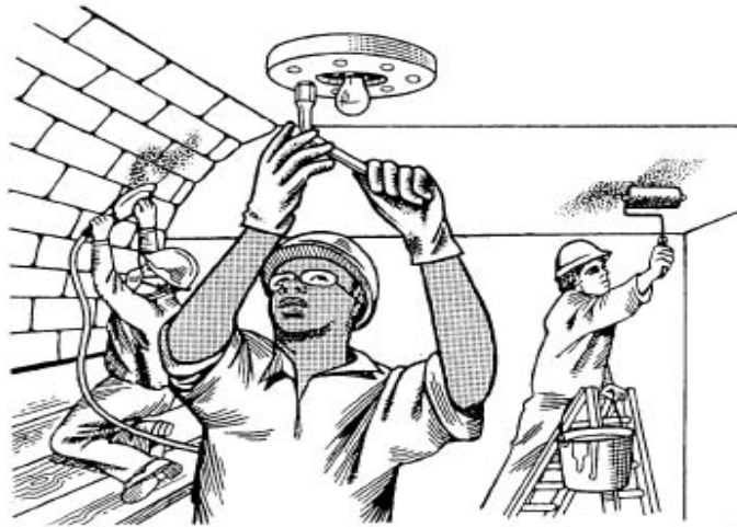
Figura 3.5. Dentro de lo posible, los obreros no deben trabajar en superficies que estén por encima de sus cabezas, ya que ello aumenta el esfuerzo de brazos, espalda y cuello.
