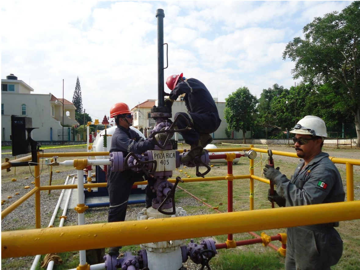
Fig. 3.1 Recuperación de una Bomba Hidráulica Tipo Jet
