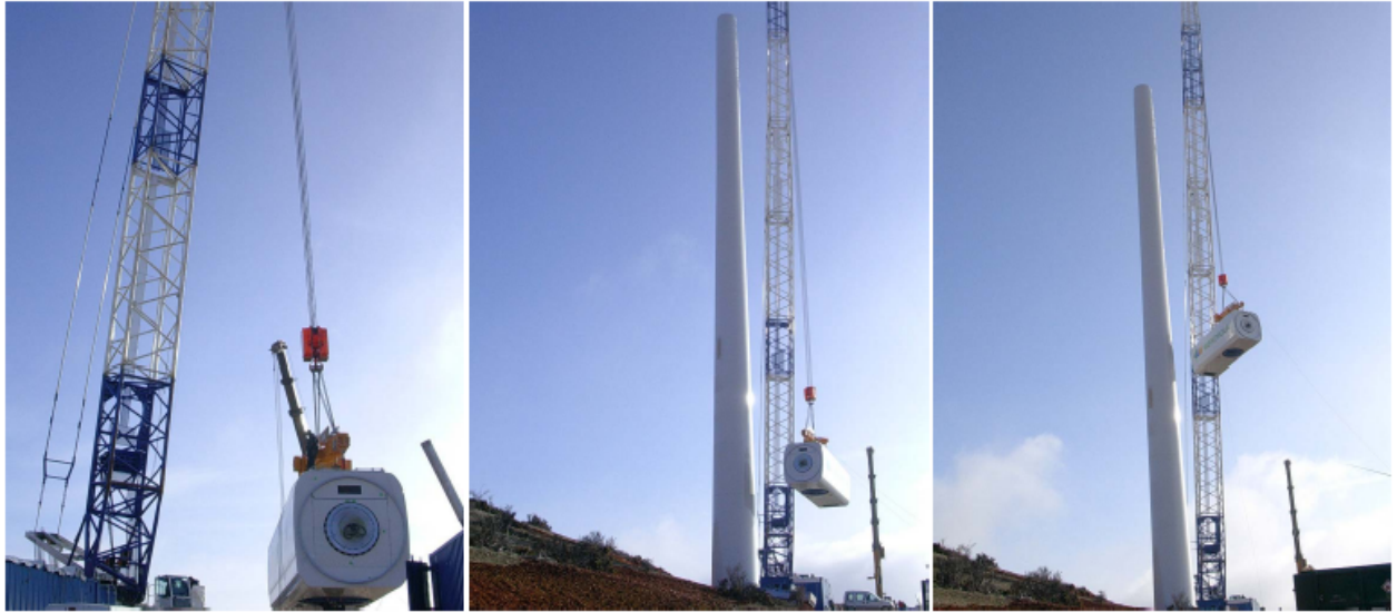
Figura 3.37 Montaje de Nacelle o Góndola. Fuente. IBERDROLA
