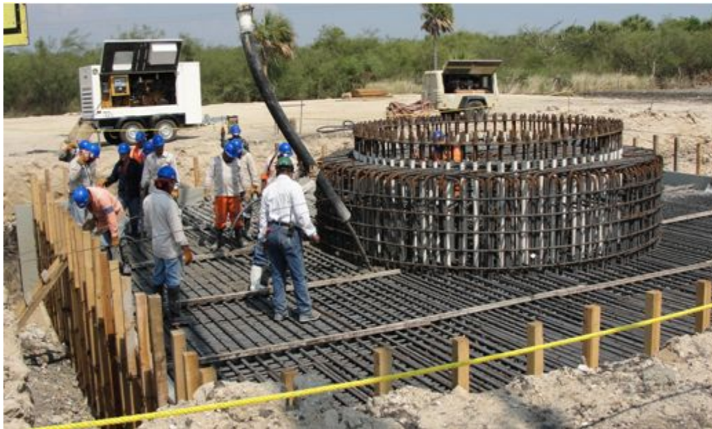
Figura 3.29 Armado y hormigonado de cimentación para aerogenerador Fuente. FUERZA EÓLICA
