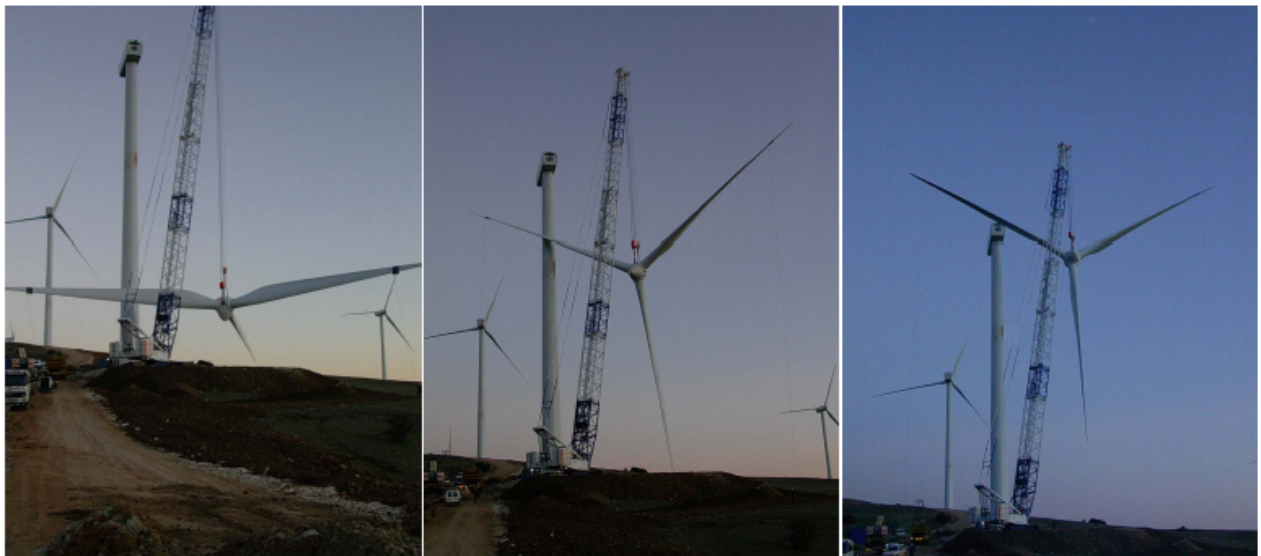
Figura 3.42 Montaje de rotor y aspas de aerogeneradores. Fuente. IBERDROLA
