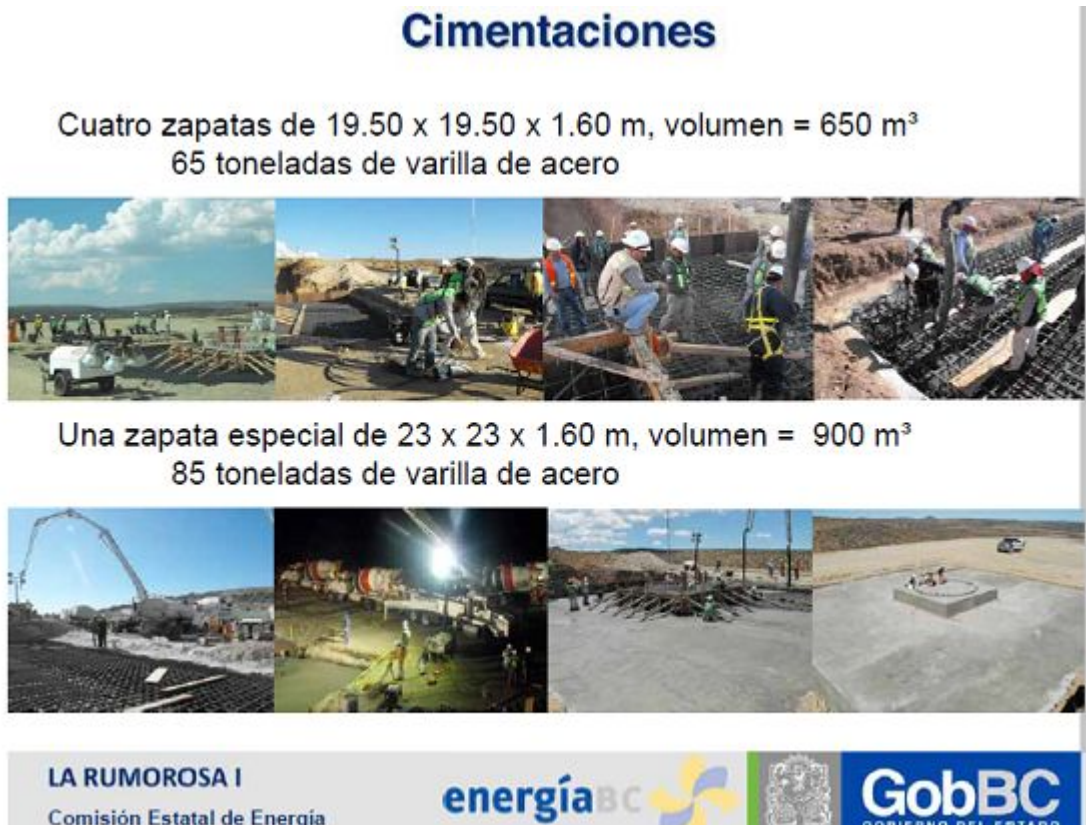
Figura 3.27 Obra civil de un parque eólico con aerogeneradores de 2 MW. Fuente. Gobierno Estatal De Baja California.
