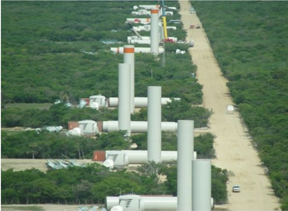
Figura 3.35 Montaje de secciones de torre de aerogeneradores. Fuente. FUERZA EÓLICA
