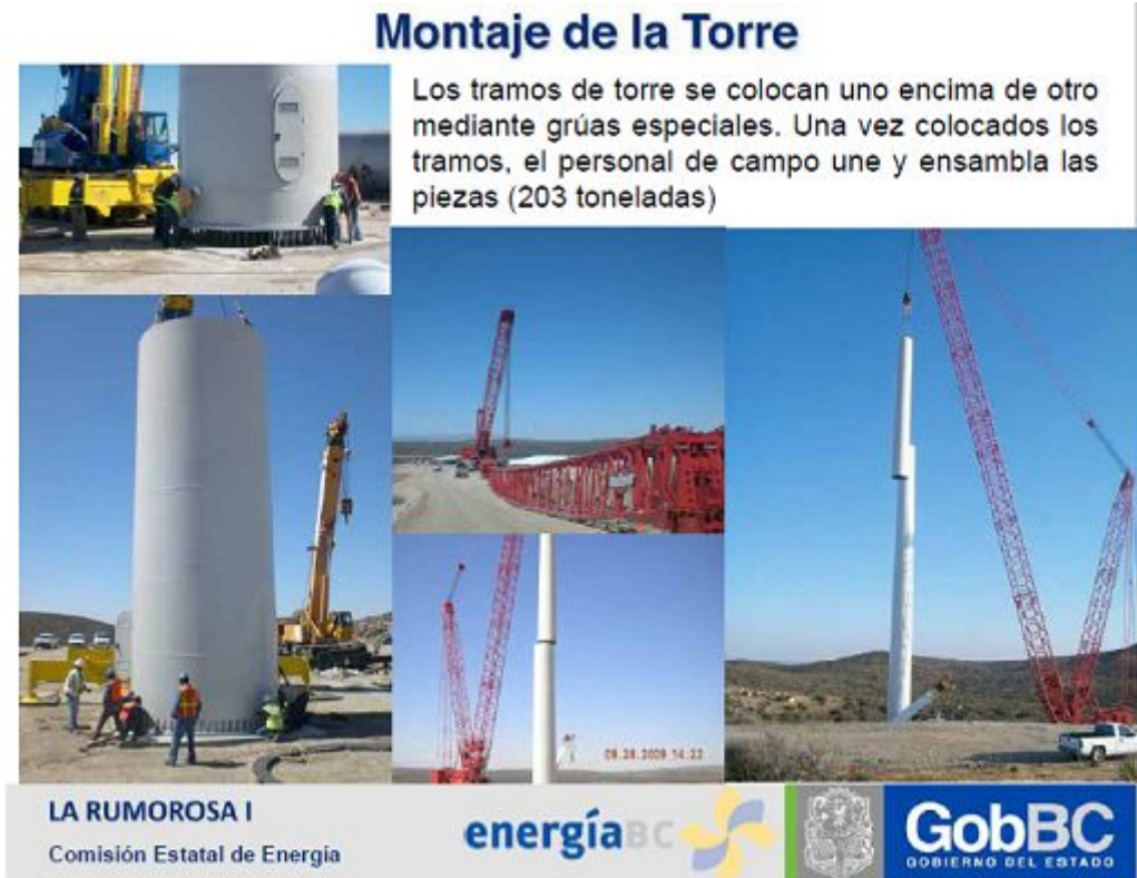
Figura 3.34 Montaje de un parque eólico con aerogeneradores de 2 MW. Fuente. Gobierno Estatal De Baja California.
