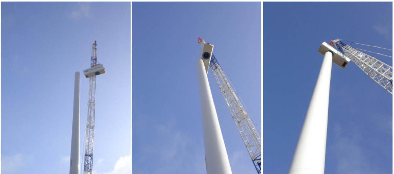
Figura 3.38 Montaje de Nacelle o Góndola. Fuente. IBERDROLA
