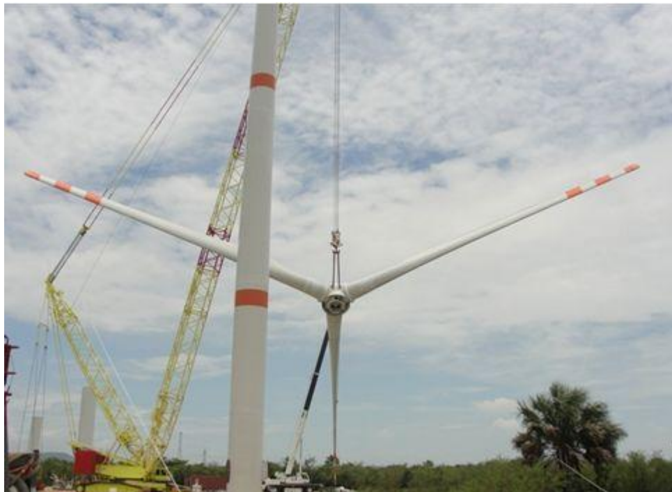
Figura 3.40 Montaje de rotor y aspas de aerogeneradores. Fuente. FUERZA EÓLICA.
