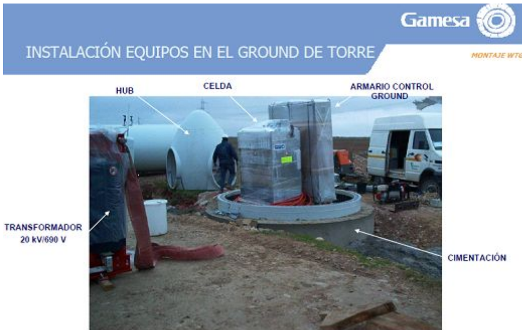
Figura 3.33 Ejemplo de montaje de equipos en plataforma de la torre. Fuente. GAMESA
