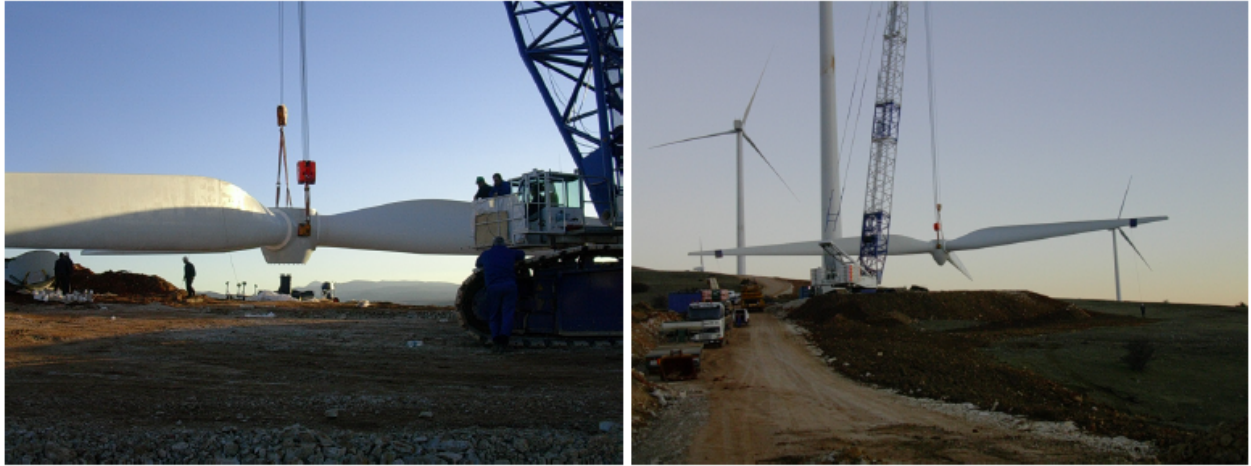
Figura 3.41 Montaje de rotor y aspas de aerogeneradores. Fuente. IBERDROLA
