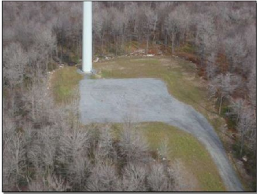
Figura 3.24 Plataforma de montaje para aerogeneradores. Fuente. GAMESA
