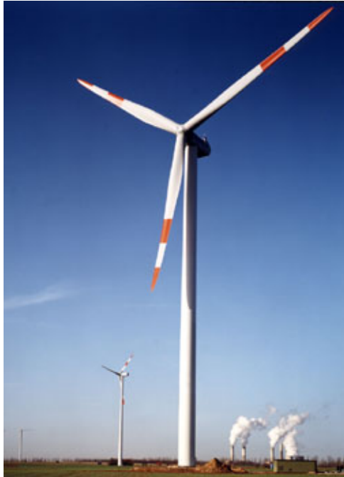
Figura 1.24. Aerogenerador de eje horizontal, tripala, barlovento.
