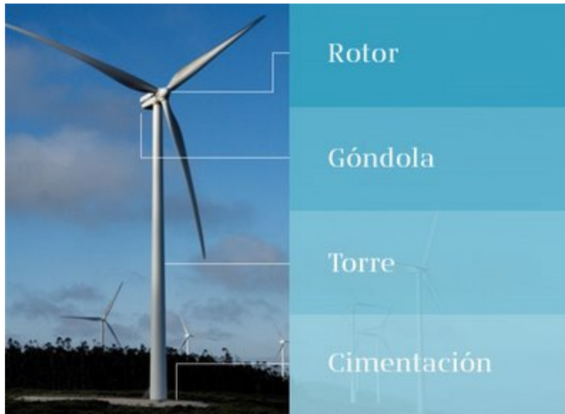
Figura 1.25. Secciones esenciales de un Aerogenerador moderno para generar electricidad.
