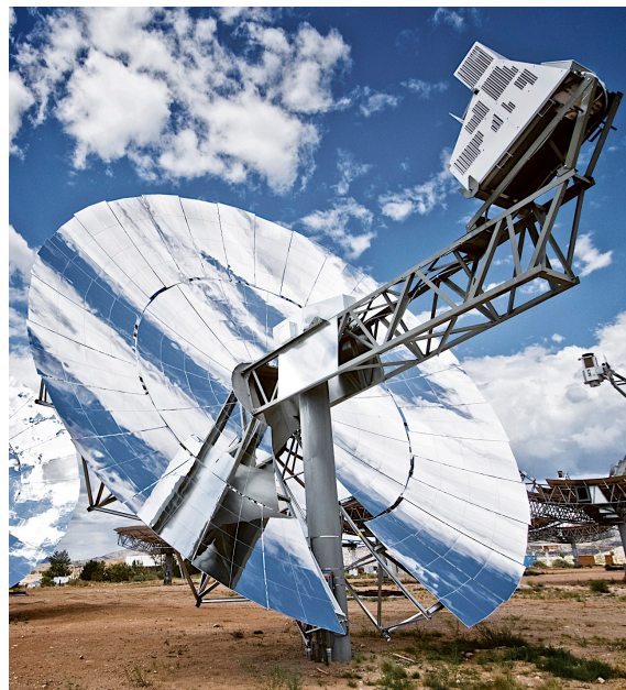
FIGURA 1 - 6 CONCENTRADOR PARABÓLICO Y MOTOR STIRLING CON GENERADOR ADJUNTO
