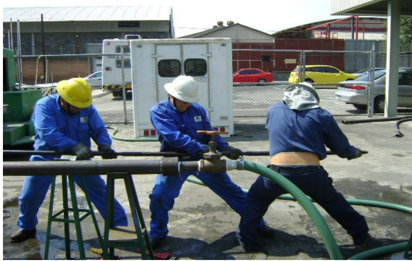
Fig. 5.9. Pruebas de anclaje en tubería de 2 7/8”.
