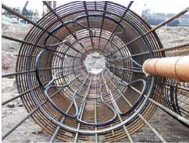
Fig. 39 "Instalación del circuito primario en la pared interna del pilote (groen energy, 2012) "
