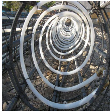
Fig. 36 " Configuración de la tubería de intercambio de calor tipo espiral (Toledo, et al., 2002) "
