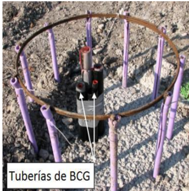
Fig. 41 " Instalación del circuito primario en el centro de la pila de cimentación (Toledo, et al., 2002) "
