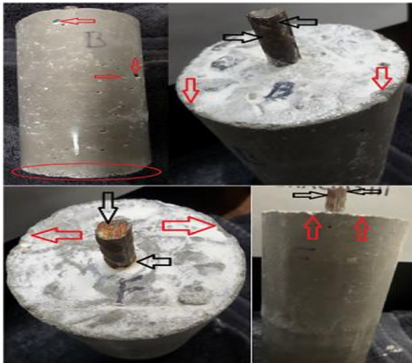
Figura 4.13. Deterioro de las probetas sometidas a gases y solución salina al 3.5%, al finalizar los 240 ciclos
