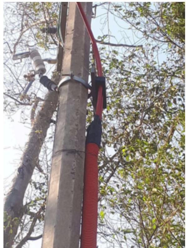
Imagen C. 47. Colocación de los accesorios para la vestimenta del poste. Aquí se hizo la conexión a la línea de distribución.
