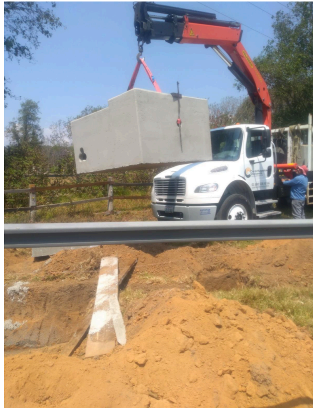
Imagen C. 41. Suministración de los registros de concreto prefabricado de diferentes dimensiones. Su descarga se hizo por medio de grúa articulada en el área definida para el proyecto.
