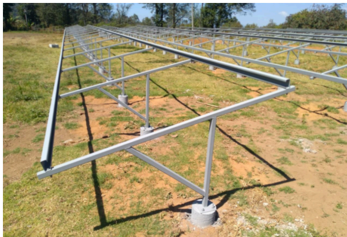
Imagen C. 39. Colocación y acabado de la estructura metálica a base de montenes.
