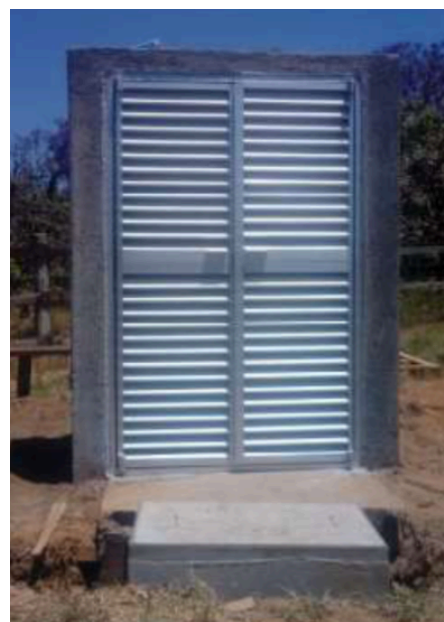
Imagen C. 45. Construcción del nicho que aloja el tablero de protección. Recibirá la corriente generada por los 3 inversores y por medio de la salida e interruptor principal a un voltaje de 480 V alimentará el transformador de 225 KVA (Volts-Amperes). Se añadió una puerta de aluminio.
