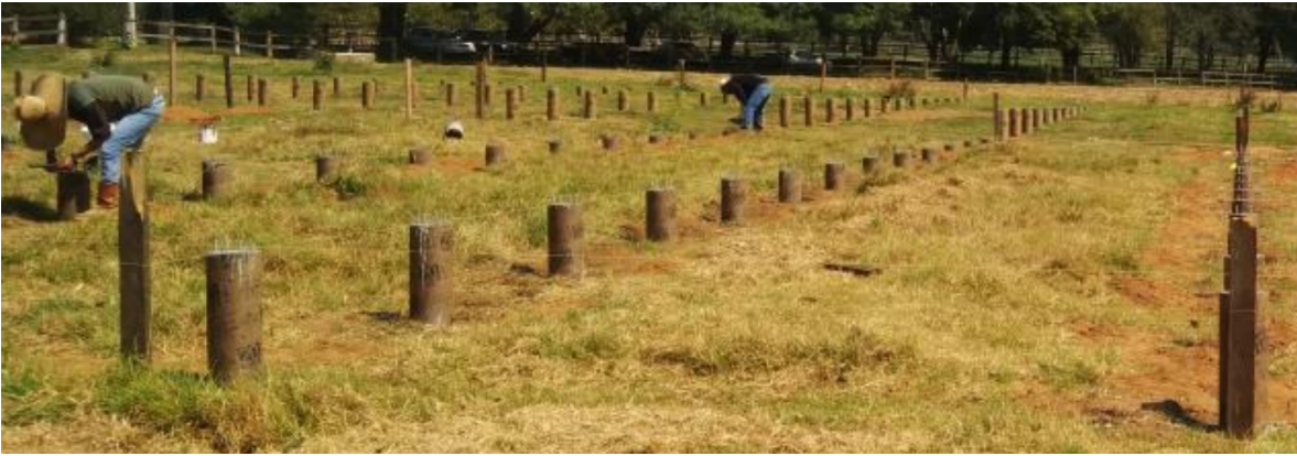
Imagen C.38. Colado de las bases.
