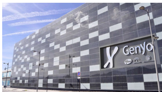
Imagen C. 50. Centro de Genómica e Investigación Oncológica (GENyO) en la Universidad de Granada, España. Fachada fotovoltaica diseñada por la empresa Onyx Solar. Genera 32 MWh/año.
