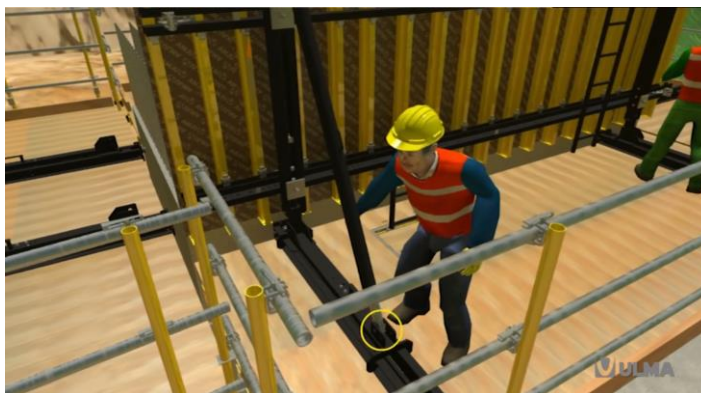
Fig. 29 x. Detalle de la fijación con perno entre puntal con el carro de retranqueo. Recuperado de: https://www.youtube.com/watch?v=8DesVSJeDJE
