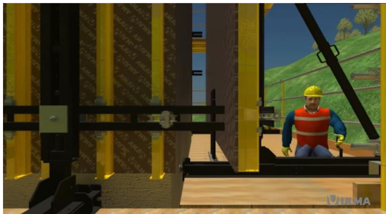
Fig. 29 ae. Retranqueo del paño después del endurecimiento del concreto.
