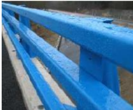
Figura 48. Parapeto con recubrimiento dúplex sobre acero.
