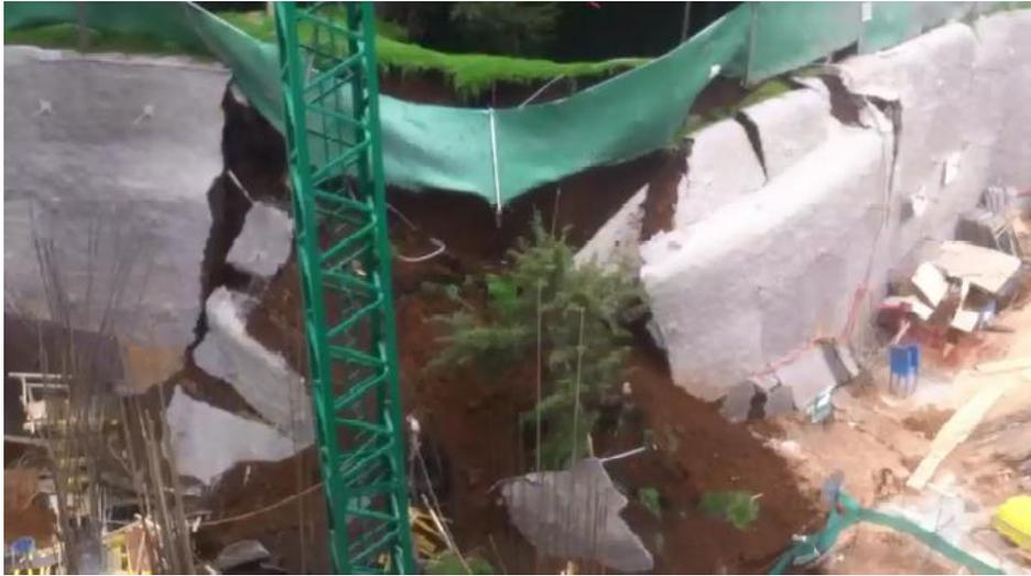
Figura IV.3 Vista frontal de la falla estructural del concreto lanzado complementado con anclas de tensión (Dominguez, 2020).
