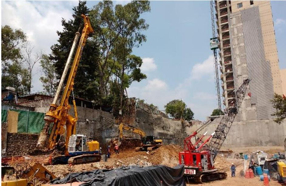
**Figura IV.1** Excavación profunda para un cajón complementado con pilas de cimentación en zona de lomas de la Ciudad de México (Dominguez, 2020).
