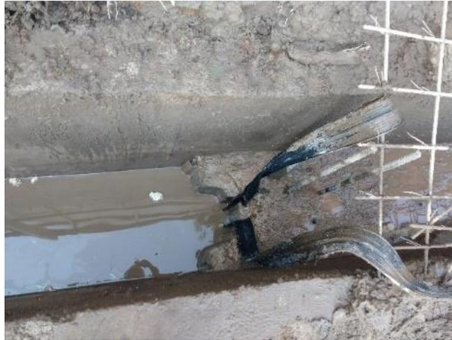
Figura V.2 Junta machimbrada con banda water-stop en panel primario, fotografía durante excavación de panel secundario.
