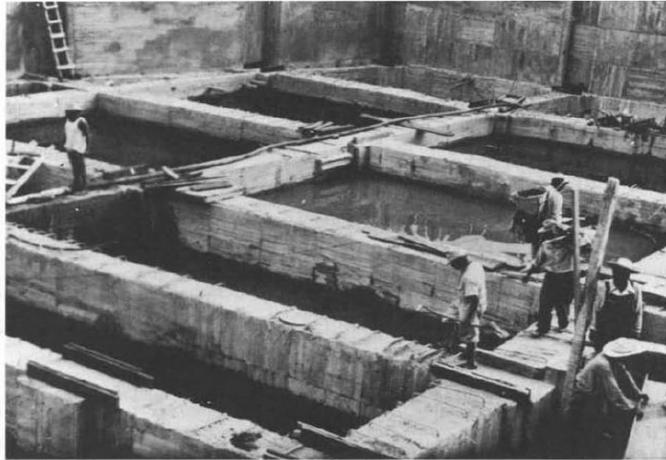
Figura III.17 Método de excavación y sustitución mediante lastre para la torre Latinoamericana (Zeevaert, 1983).
