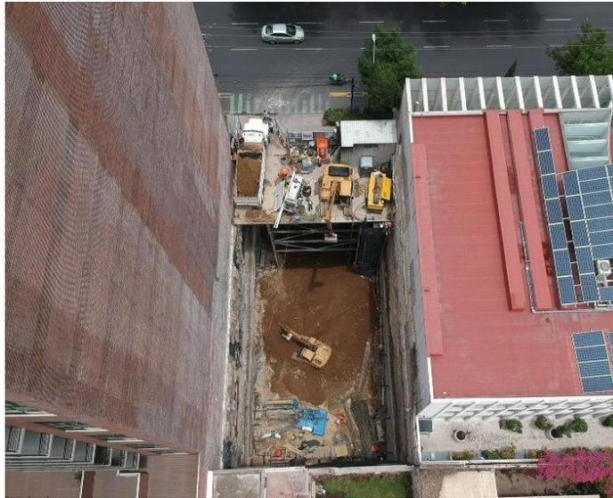
Figura IV.52 Ejemplo de una plataforma de acero temporal para proceso de excavación (Paniagua, 2020).
