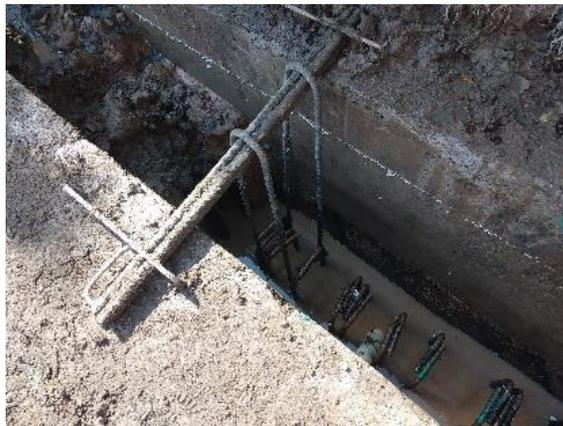
Figura V.1 Brocal de concreto armado con orejas para trapeado y mantener fijo en su posición el armado durante el colado.
