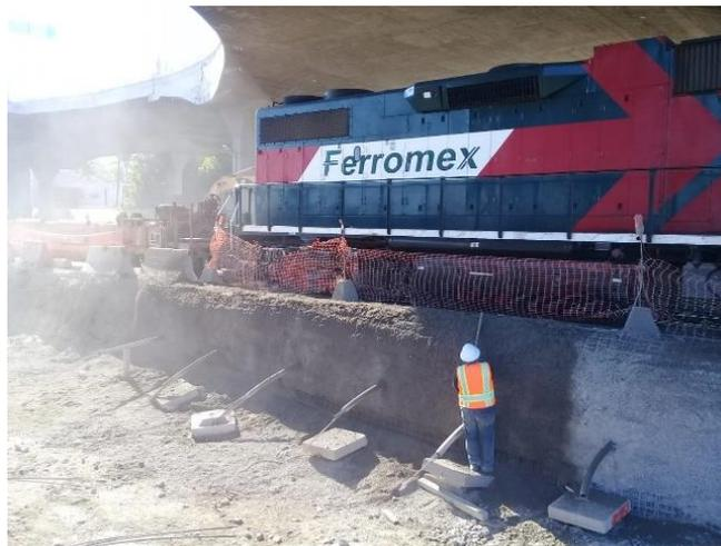
Figura IV.4 Vista frontal de la excavación con los rieles de ferrocarril en uso.
