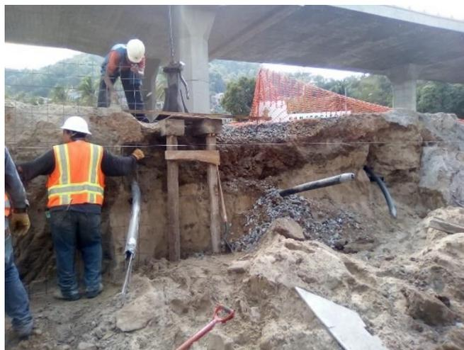
Figura IV.6 Trabajos adicionales de relleno de fallas locales con mortero fluido.
