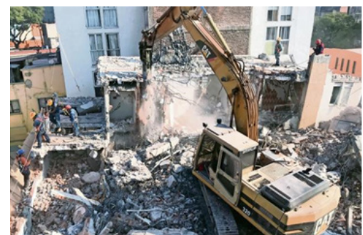
Figura 5: Demolición en Escocía 29.
