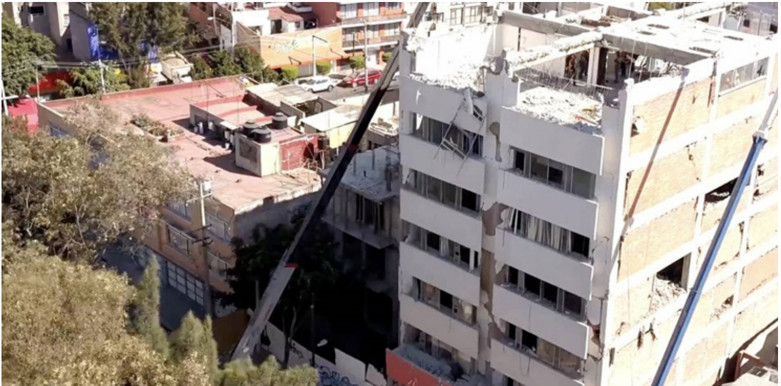
FIGURA 27: Toma aérea del edificio ubicado en calle Escocia 29, delegación Coyoacán, 2017, Ciudad de México.
