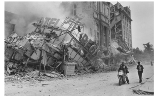
FIGURA 8: Escombros de la caída del Hotel REGIS, 1985, Distrito Federal.
