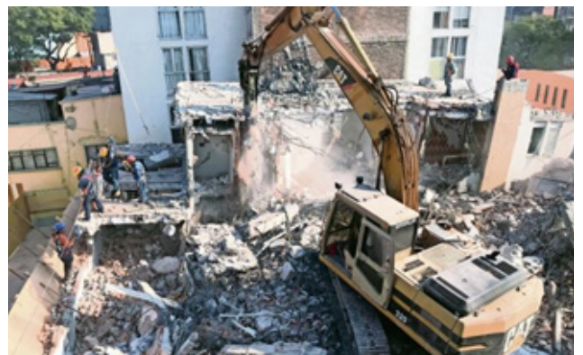
PROCESO DE DEMOLICIÓN INICIADO EN ESCOCIA 29.
