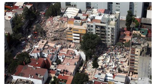
FIGURA 23: Vista aérea de la colisión del colegio Enrique Rébsamen, 2017, Ciudad de México.
