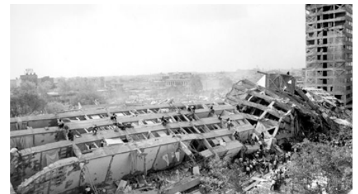
FIGURA 17: En el derrumbe del edificio Nuevo León de Tlatelolco murieron entre 200 y 300 personas, 1985, Distrito Federal
