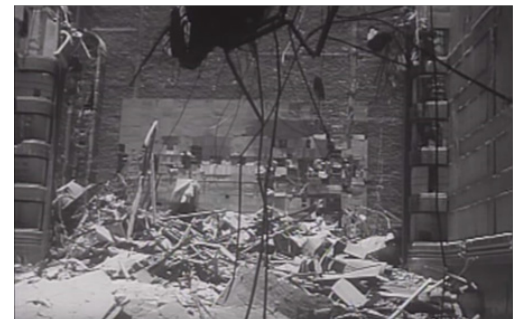
FIGURA 11 Y 12: CINE ENCANTO, COLAPSO 1957, DISTRITO FEDERAL.
