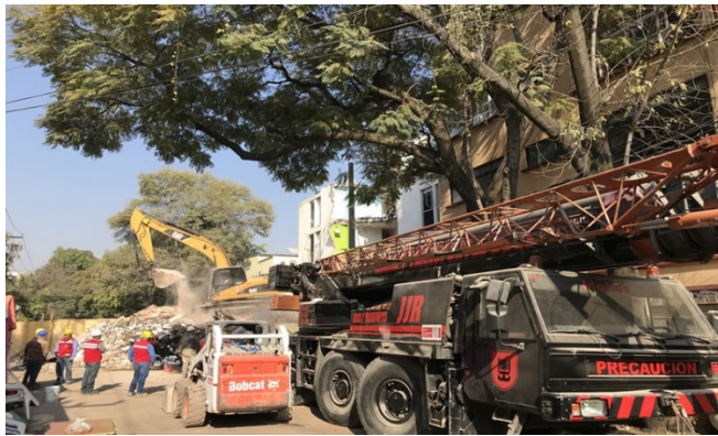
LA DEMOLICIÓN EN ESCOCIA 29, MAQUINARIA QUE DERRUMBARA EL EDIFICIO.
