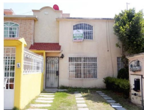
FIGURA41: Vivienda de interés social, establecida en, cofradía 1 Cuautitlán Izcalli estado de México, colindante con el fraccionamiento de paseos Izcalli, Urbi Quinta Montecarlo y cofradía II y III, todas estas con las características de una vivienda de interés social.
