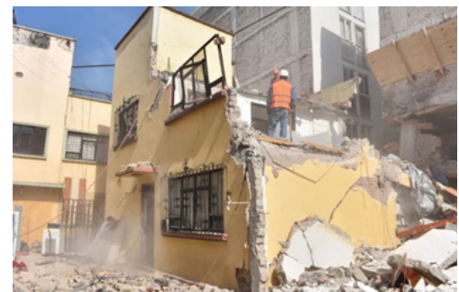
Figura 4: Demolición en Escocía 33.
