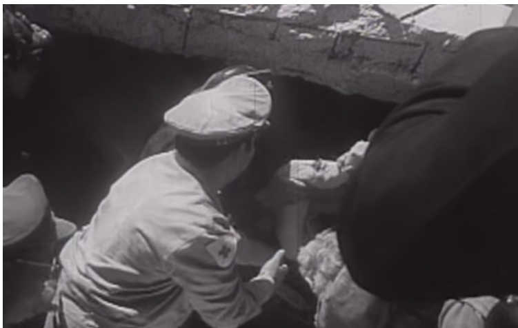
Figura 16: Extracción de personas en inmueble en Álvaro Obregón, colapsado, 1957, Distrito Federal.
