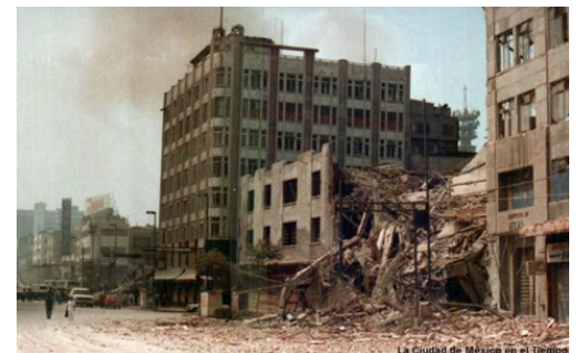
FIGURA 18: Las construcciones en la avenida Eje Central fueron de las más afectadas, 1985, Distrito Federal
