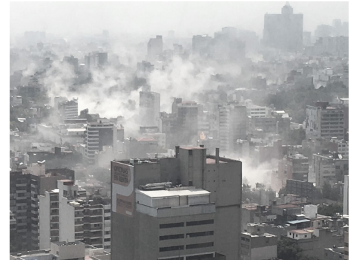
FIGURA 38: Colapso en la ciudad, 46 inmuebles identificados en la ciudad, periodico La Razón
