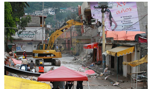
FIGURA 24: La tragedia de Xochimilco, edificios habitacionales en demolición, 2017, Ciudad de México.
