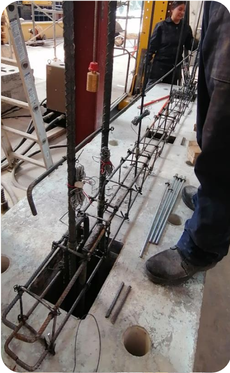
Figura 4.5 Anclaje a la base, cadena de desplante 16x20 cm
