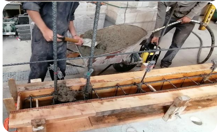
Figura 4.5 Anclaje a la base, cadena de desplante 16x20 cm
