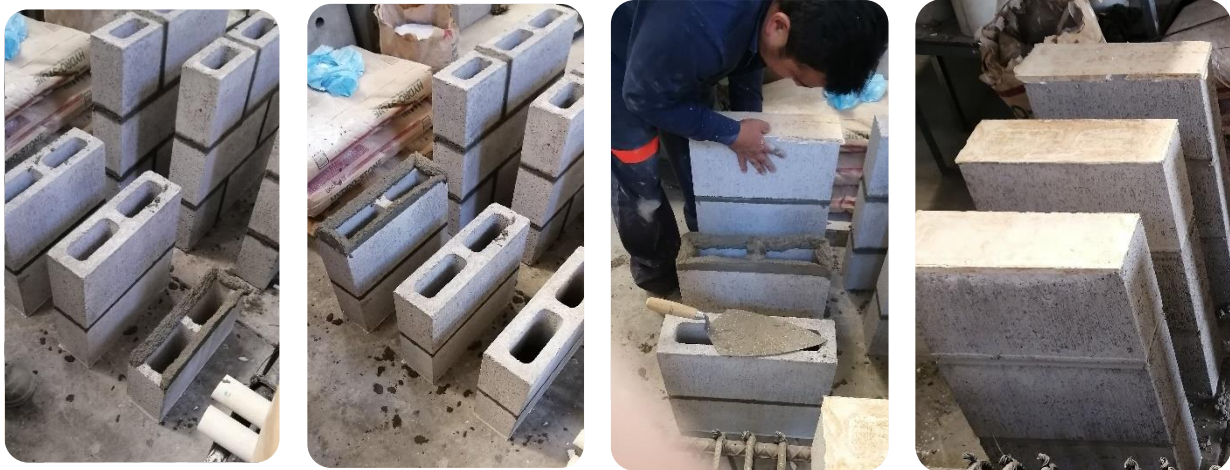
Figura A.2 Construcción de pilas a compresión
