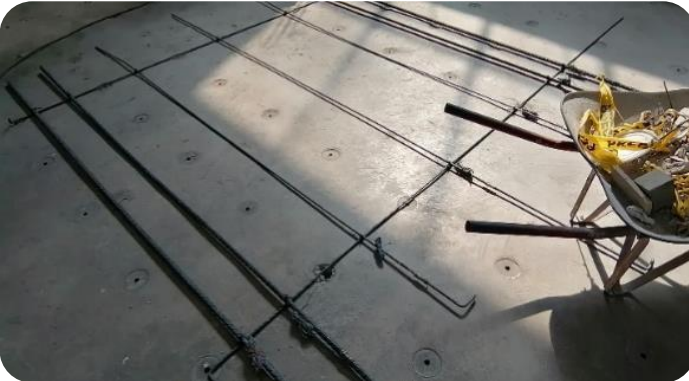
Figura 4.4 Armado de muro con refuerzo interior
