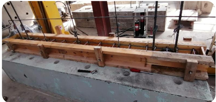
Figura 4.4 Armado de muro con refuerzo interior
