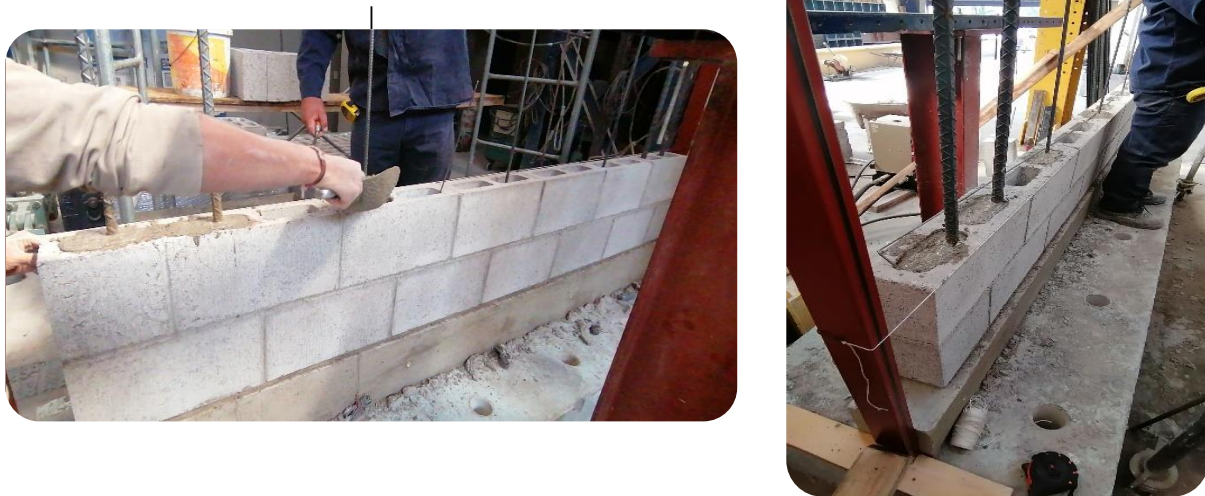
Figura 4.7 Relleno de celdas con refuerzo
