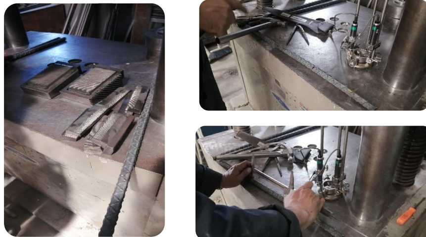
Figura A.10 Preparación de barras de acero de refuerzo
