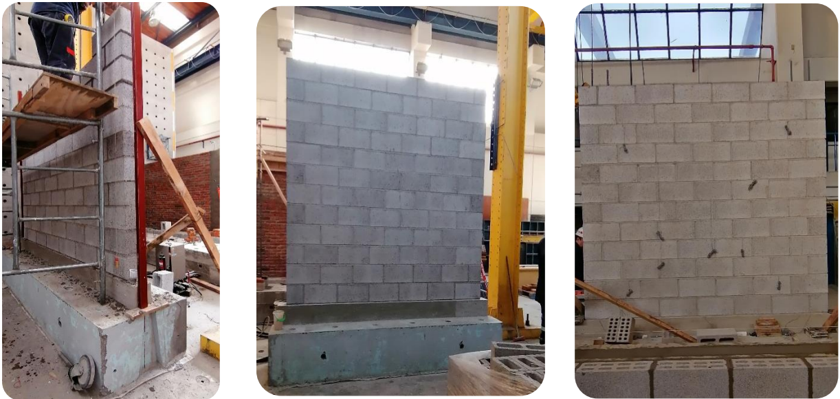
Figura 4.9 Espécimen MBRI-8, muro con refuerzo interior.
