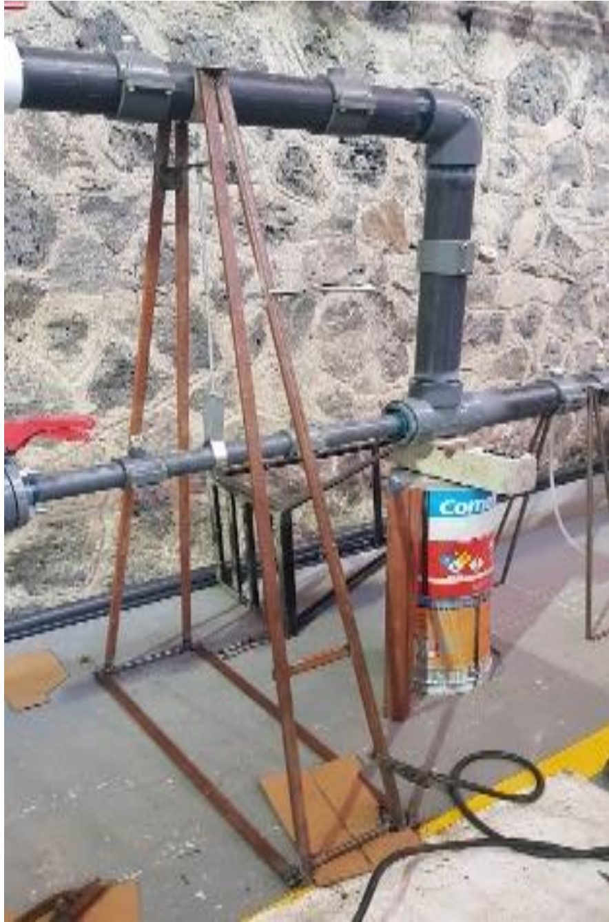
Fig 10c Ensamble y fijacion del siguiente soporte, empleando soldadura elêctrica.
