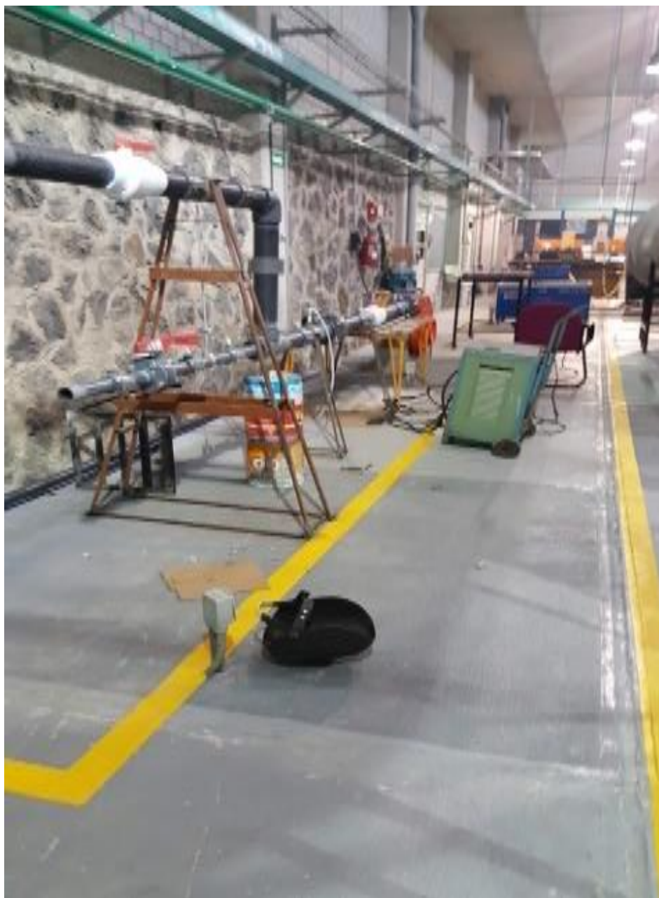
Fig. 10 d1 Colocaciòn de Soporte mayor
