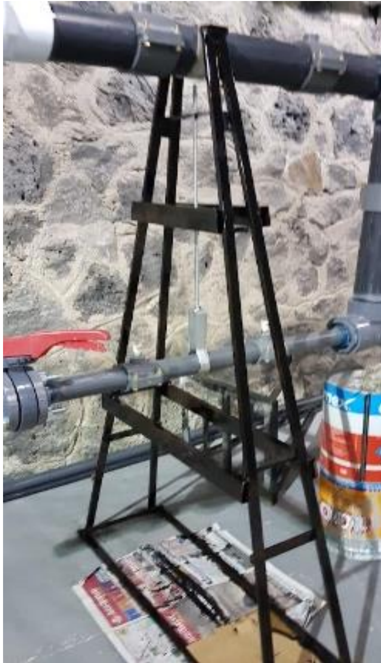
Fig. 10d 2 Aplicación de protección anticorrosiva
